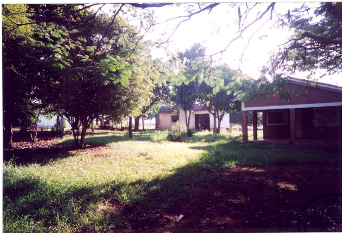
FOTO N°6: Vista de uma das casas de empregados e oficina.
