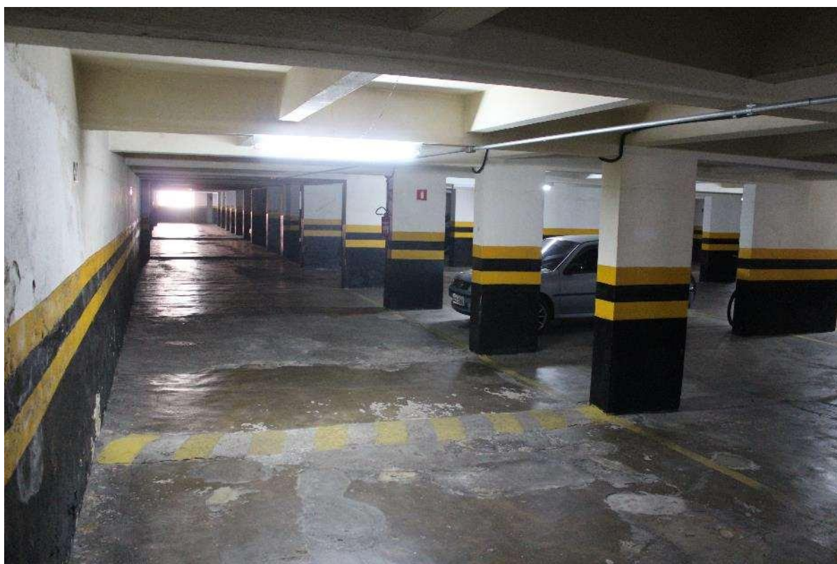
Condomínio Edifício Tristano – Garagem
