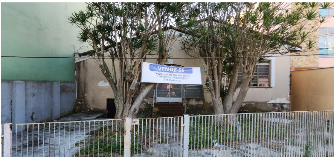
FOTO Nº 01 Vista parcial da fachada do terreno
