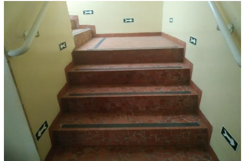
Acesso ao 1º pavimento
