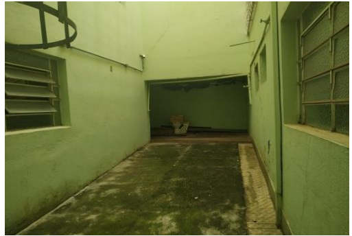
Poço de ventilação - vista 1
