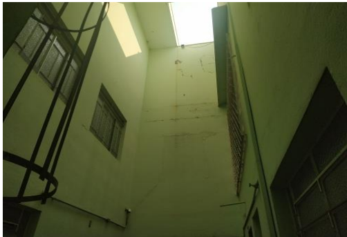
Poço de ventilação - vista 2
