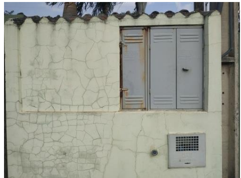
Medidor de energia e água
