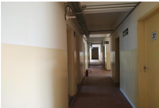
Corredor térreo vista 1
