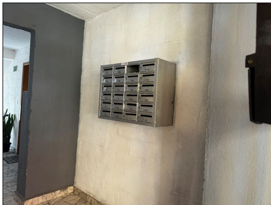
Foto 6 – Vista Interna da área comum do Bloco 52
