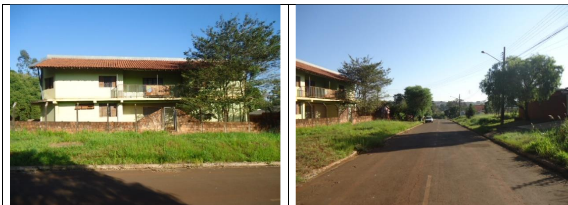
Fachada da propriedade
