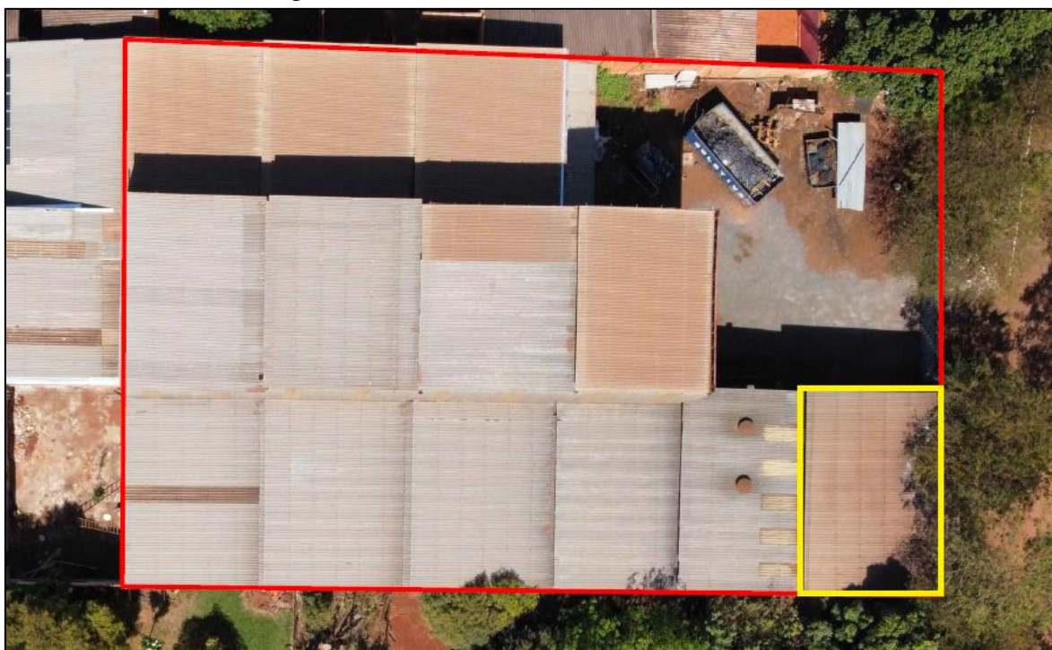
Figura 8 – Benfeitoria Imóvel Mat. 68.866
