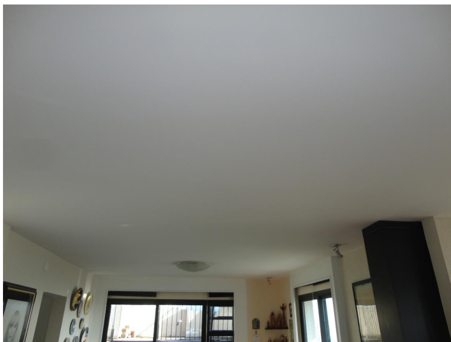
FOTO 07 – Detalhes da laje do 14º andar.
