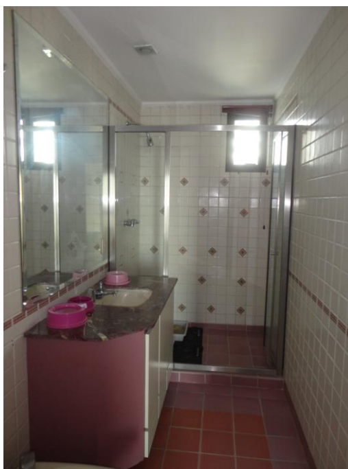
FOTO 23 – Vista geral do banheiro da suíte 02.
