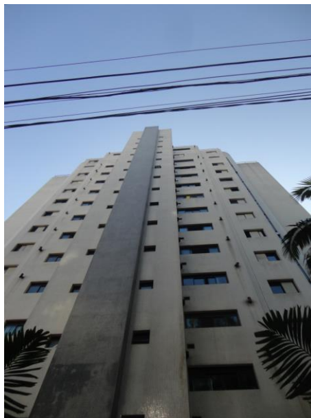
FOTO 01 – Vista geral da fachada do Prédio
