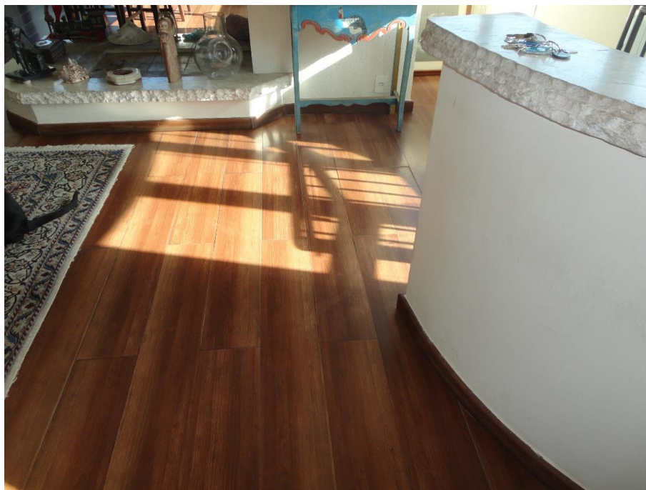
FOTO 04 – Vista geral do piso laminado no 14º andar.
