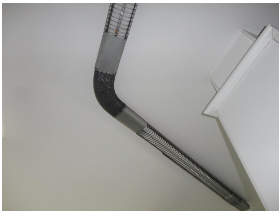
FOTO 09 - Detalhes da laje e da iluminação típica.
