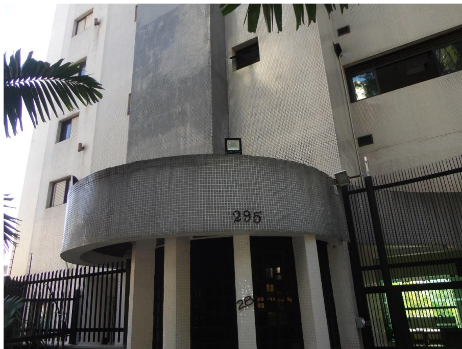
FOTO 02 – Identificação numérica do Prédio
