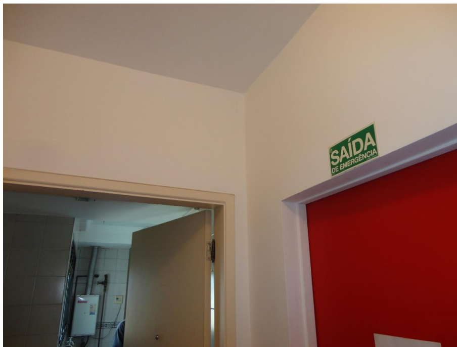
FOTO 34 – Vista geral da porta de serviço sem identificação numérica.
