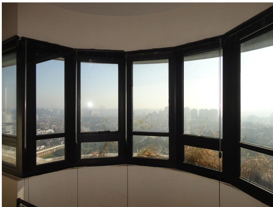
FOTO 05 – Vista geral das esquadrias em ferro do 14º andar.
