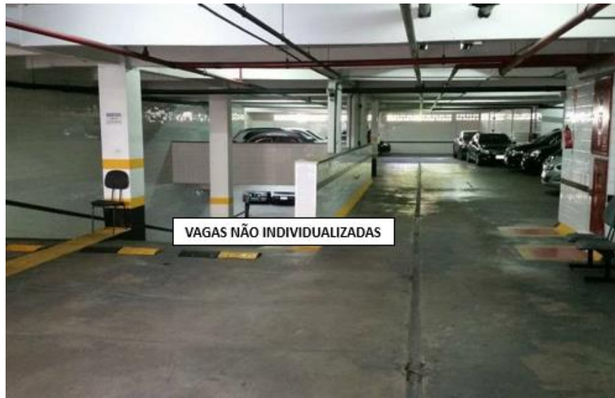
Vista parcial estacionamento do condomínio (vagas demarcadas, porém, não individualizadas)
