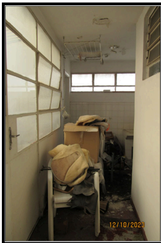
CORREDOR DE ACESSO A LAVANDERIA, QUARTO E BANHEIRO DE EMPREGADA E ÁREA EXTERNA
