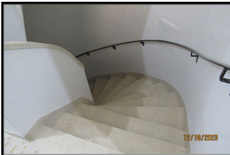
ESCALADA DE ACESSO AO 1º ANDAR ONDE ESTÁ LOCALIZADO O APARTAMENTO AVALIANDO
