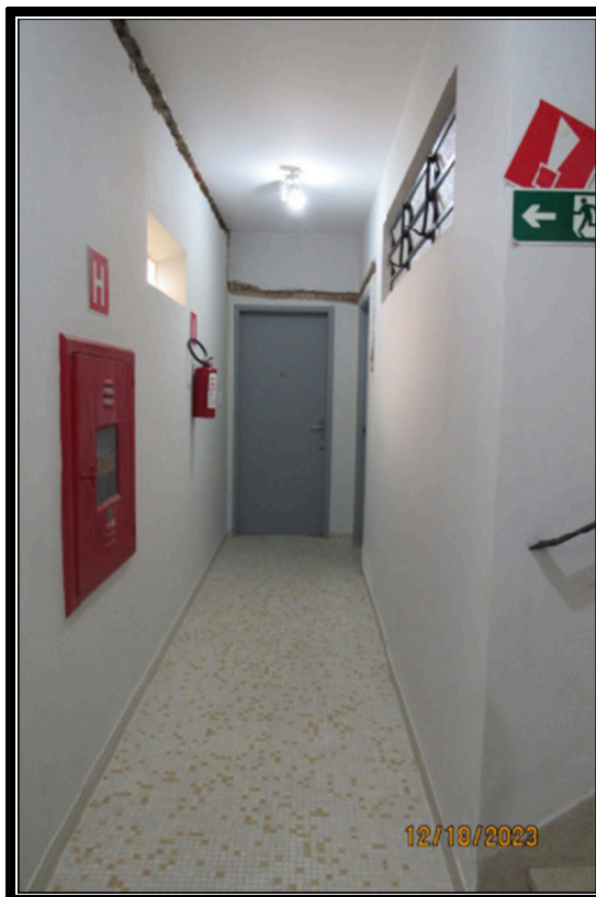
CORREDOR DE ACESSO AO IMÓVEL AVALIANDO
