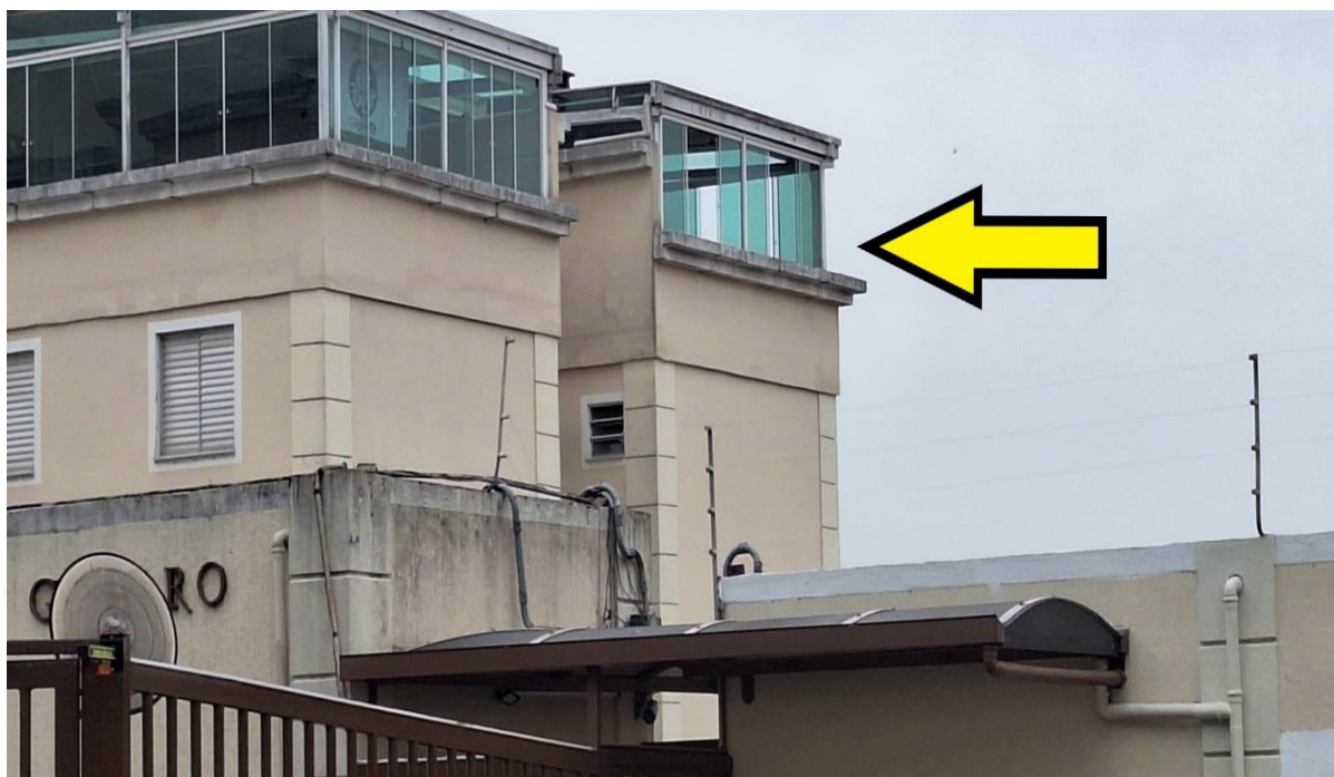
Foto 5 – Bloco 2 – no detalhe o imóvel avaliando
