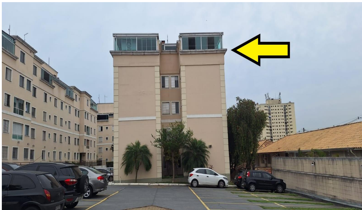
Foto 6 – Bloco 2 – no detalhe o imóvel avaliando
