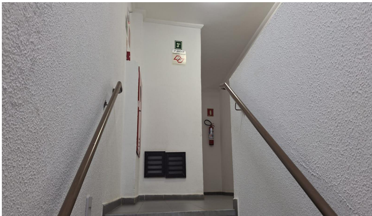
Foto 12 – Escada de acesso ao 3º andar – 4º pavimento
