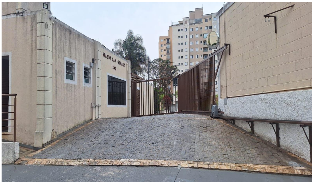
Foto 3 – Entrada de veículos
