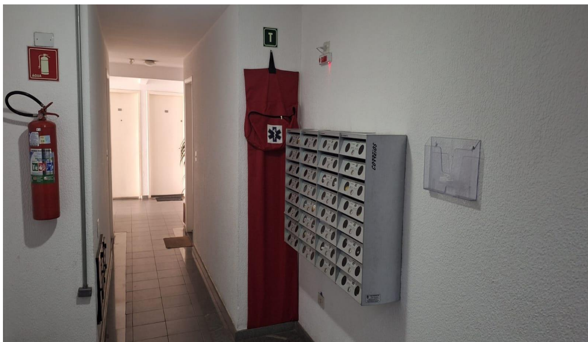
Foto 11 – Hall do Bloco 2 – pavimento térreo
