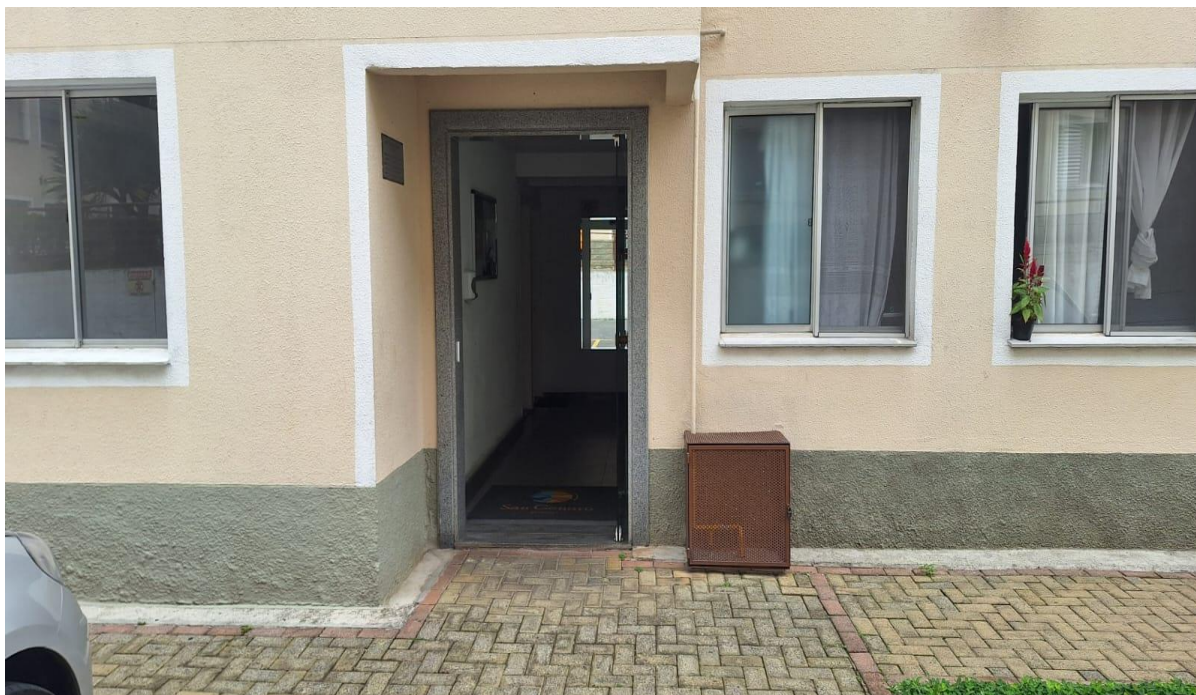
Foto 8 – Bloco 2 – porta de entrada
