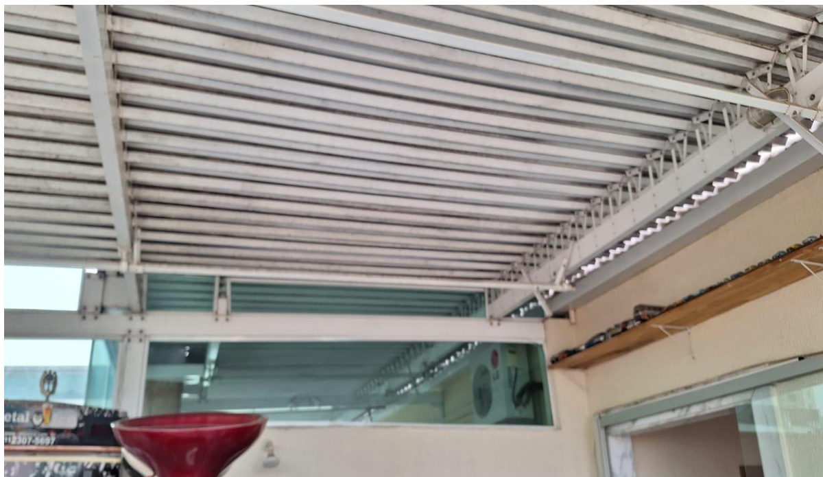
Foto 36 – Cobertura basculante em alumínio – varanda gourmet
