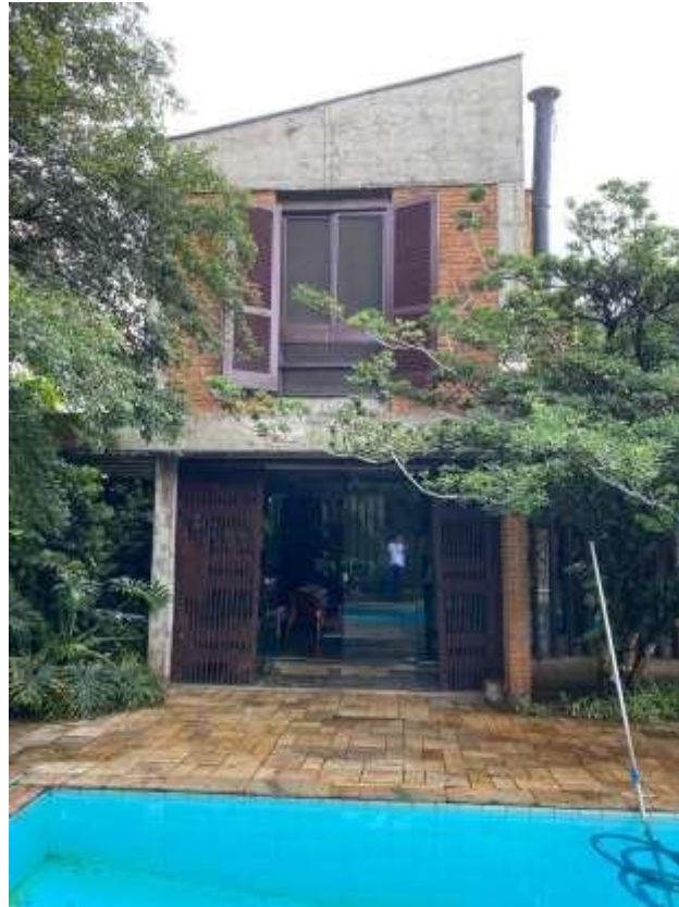
Foto 17 – Fachada dos fundos
