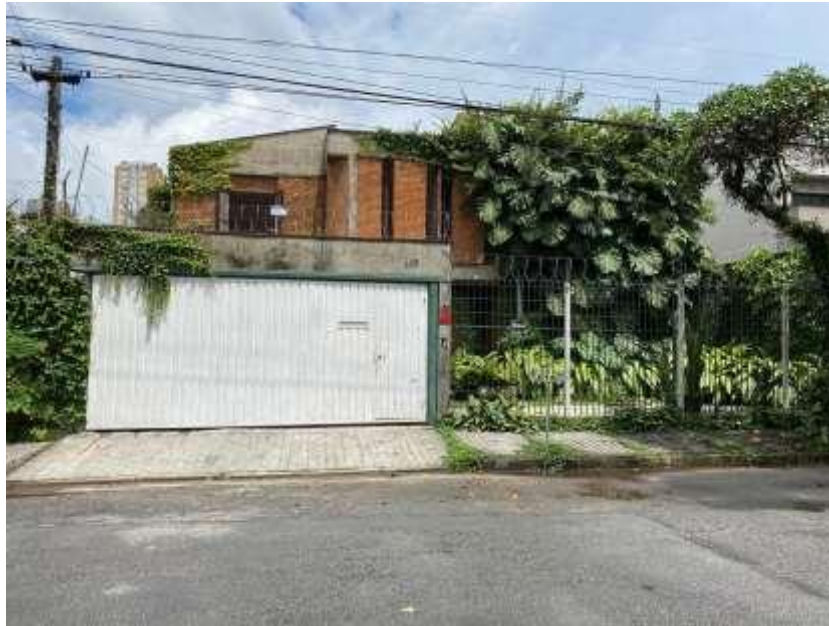
Foto 01 – Frente do imóvel avaliando: Rua Orobó, nº 145
