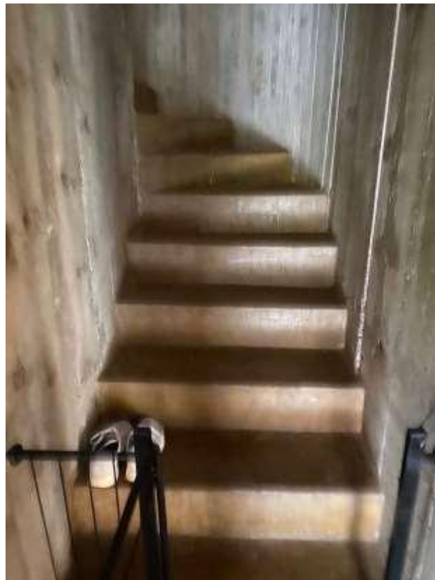
Foto 18 – Escada de acesso ao pavimento superior
