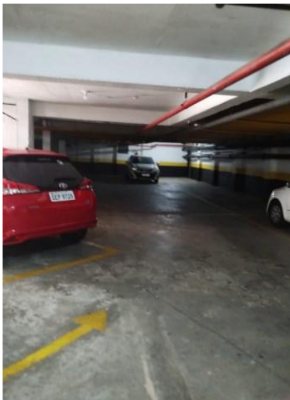
FOTO Nº 12 Vista parcial Garagem
