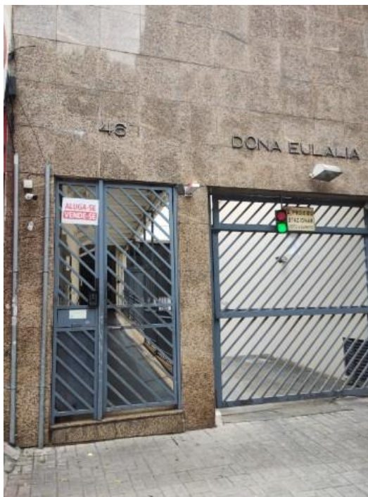
FOTO Nº 02 Vista parcial Entrada do Edifício
