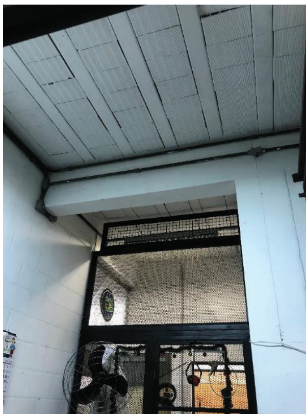
Foto 48: Dependências administrativas no pavimento térreo.
