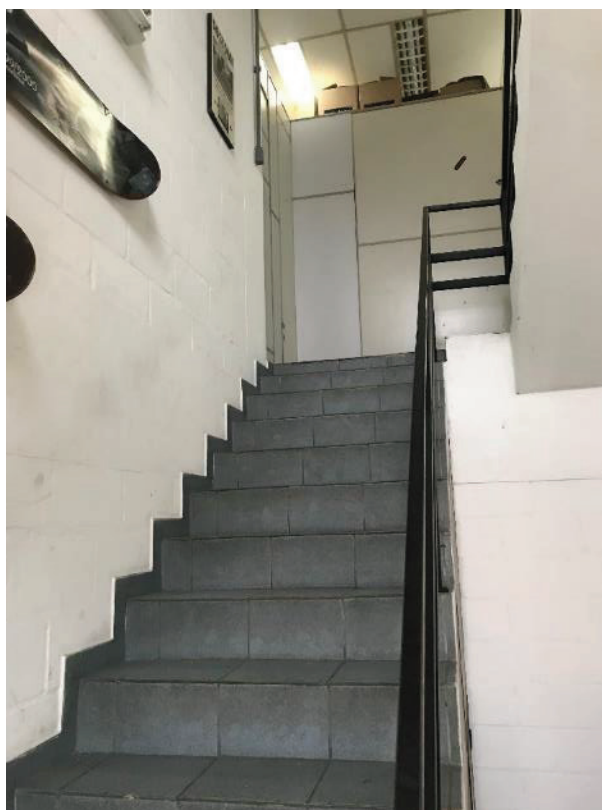
Foto 22: Escadaria do primeiro pavimento.
