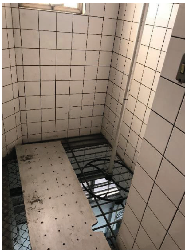
Foto 33: Vão próximo ao banheiro do primeiro pavimento.
