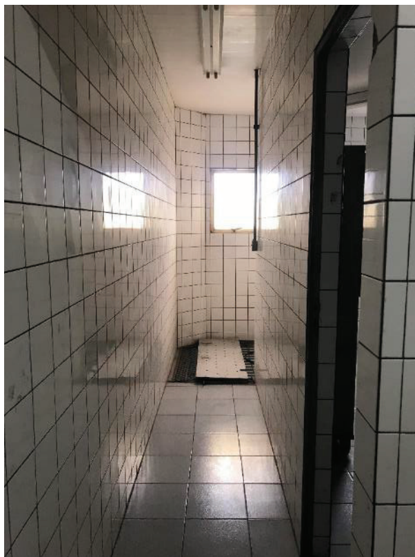
Foto 32: Vão próximo ao banheiro do primeiro pavimento.
