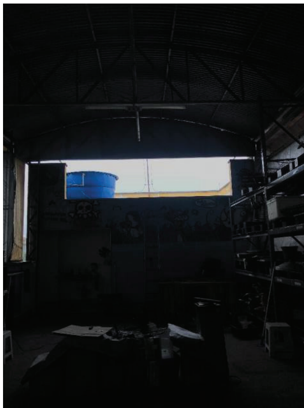
Foto 18: Salão do segundo pavimento – detalhe para o reservatório de água e para-raios instalados.
