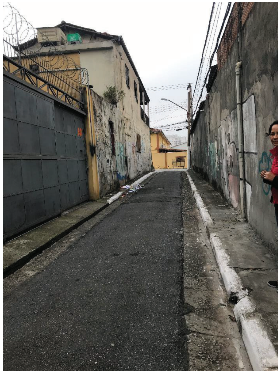
Foto 1: Vista do portão do imóvel avaliando (à esquerda, cinza) e da Rua Vila Lafemina.
