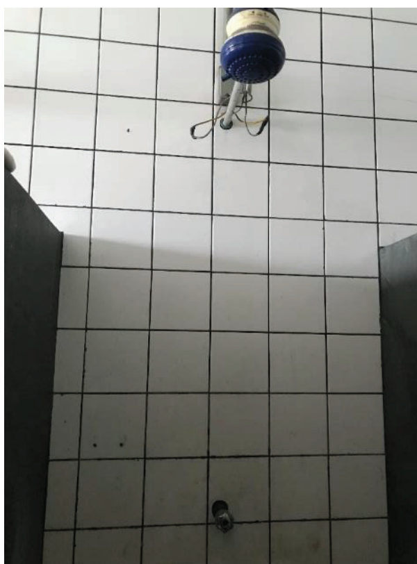
Foto 29: Vestiário do banheiro do primeiro pavimento.
