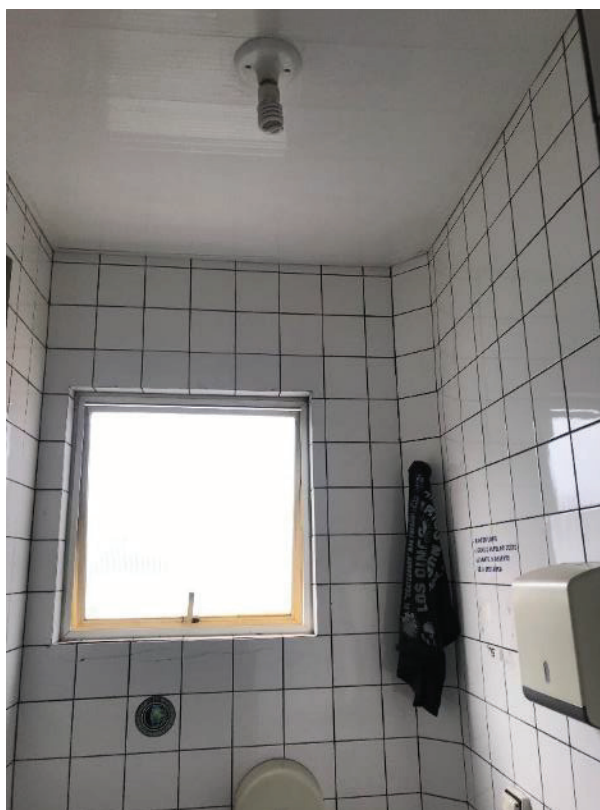
Foto 24: Banheiro do primeiro pavimento.
