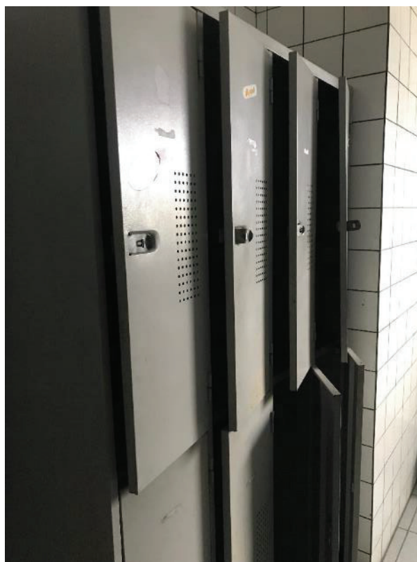
Foto 31: Vestiário do banheiro do primeiro pavimento.
