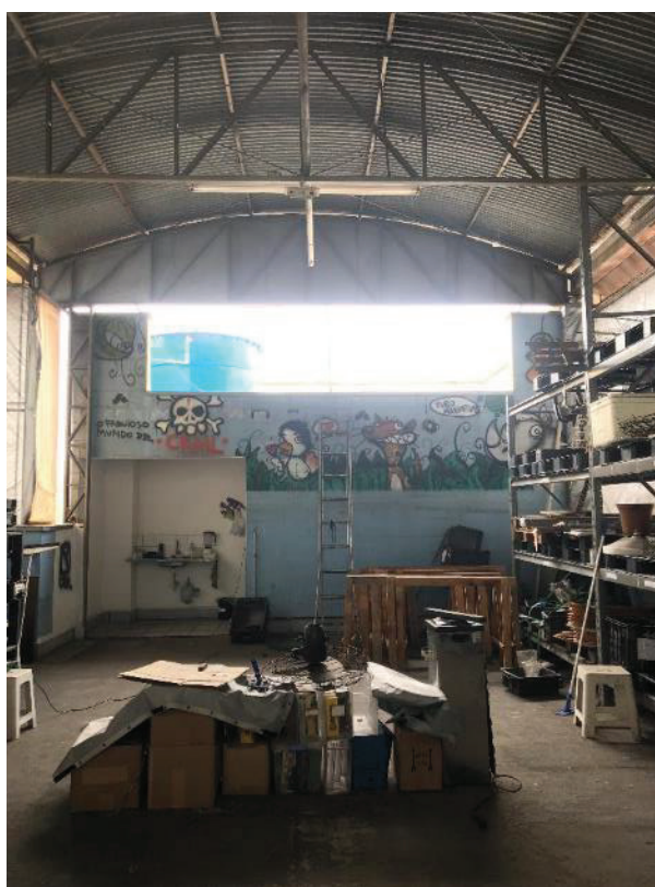
Foto 17: Salão do segundo pavimento – para estocagem de produtos prontos.
