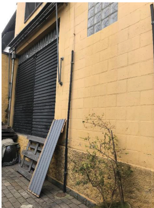
Foto 7: Vista da fachada frontal vista da fachada frontal.
