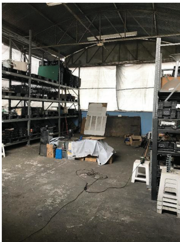
Foto 19: Salão do segundo pavimento – para estocagem de produtos prontos.
