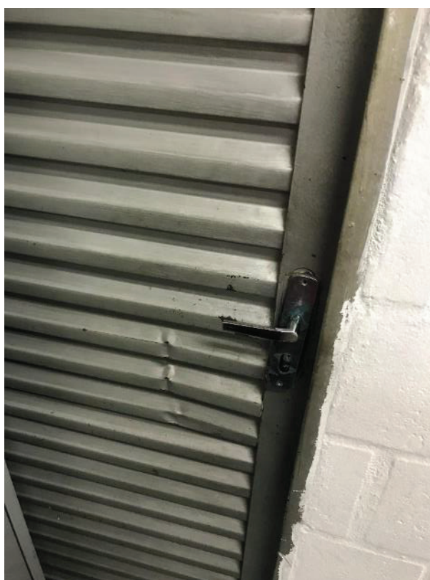
Foto 23: Banheiro do primeiro pavimento.
