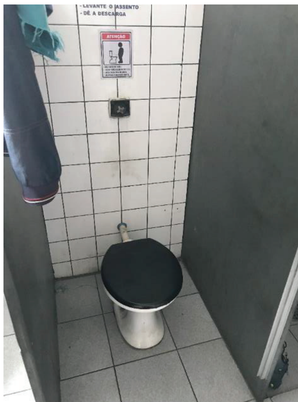
Foto 30: Vestiário do banheiro do primeiro pavimento.
