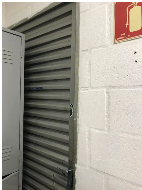
Foto 26: Acesso ao banheiro do primeiro pavimento.
