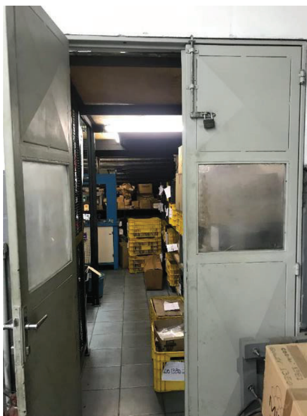
Foto 47: Acesso às dependências administrativas no pavimento térreo.
