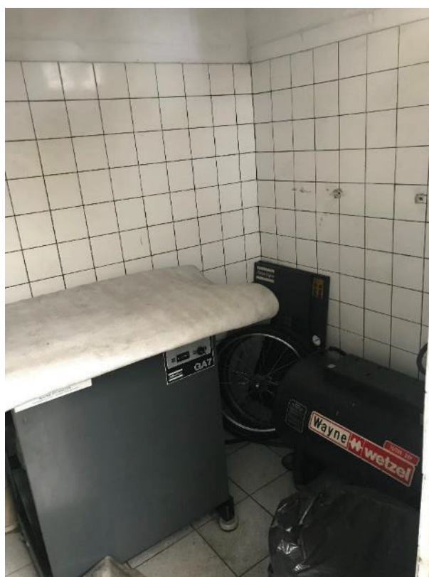
Foto 57: Área de lavagem de peças no pavimento térreo.
