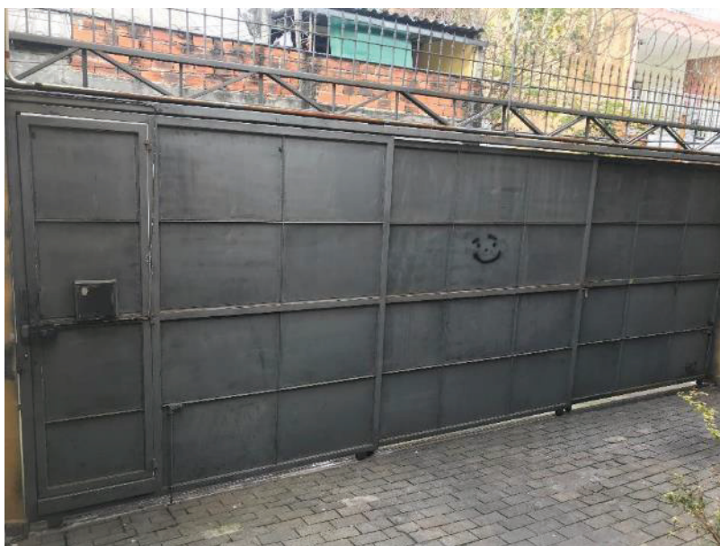
Foto 4: Vista interna do portão de acesso ao imóvel.
