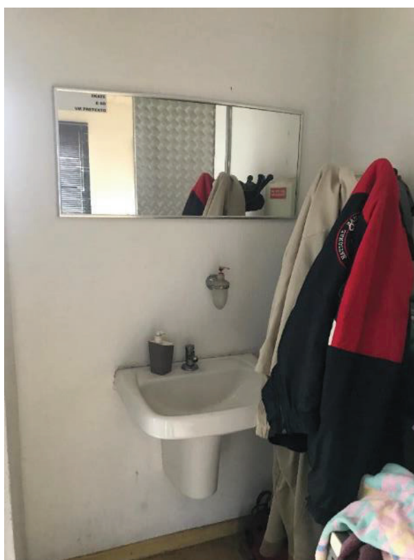
Foto 15: Banheiro do segundo pavimento.
