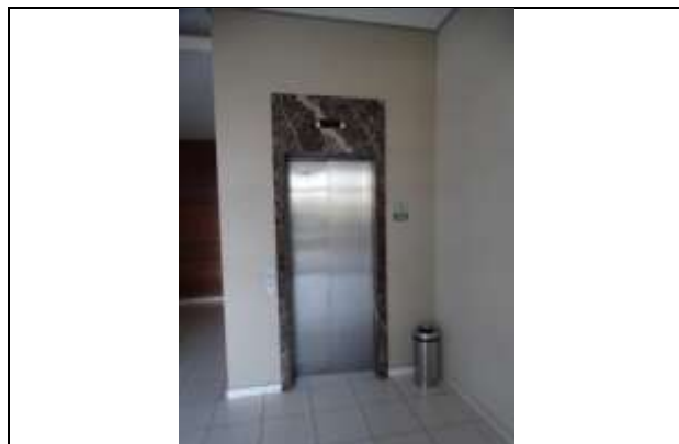
Foto 8 - Vista de elevador do condomínio.
