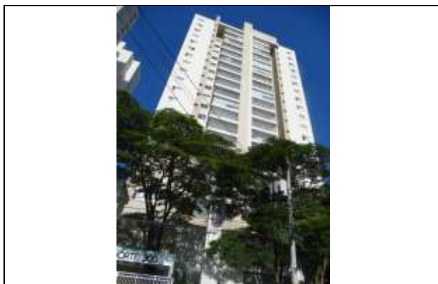
Foto 3 - Vista da Torre B do Condomínio Vista Norte.
