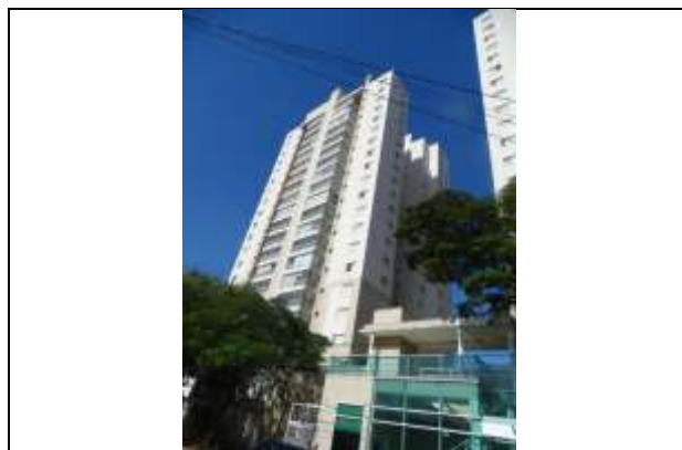
Foto 2 - Vista da Torre A do Condomínio Vista Norte.
