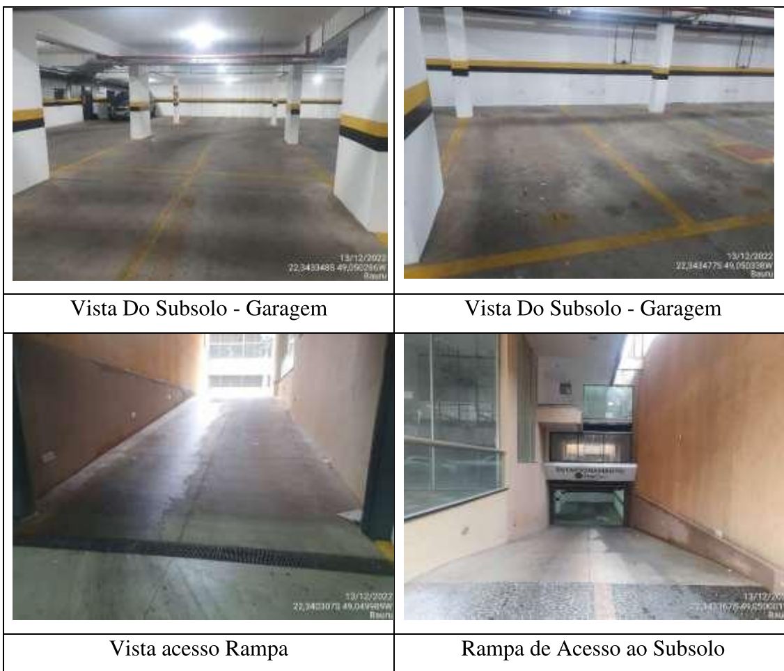
Figura 2 – Vistas Gerais do subsolo do Empreendimento Studium Residence.
