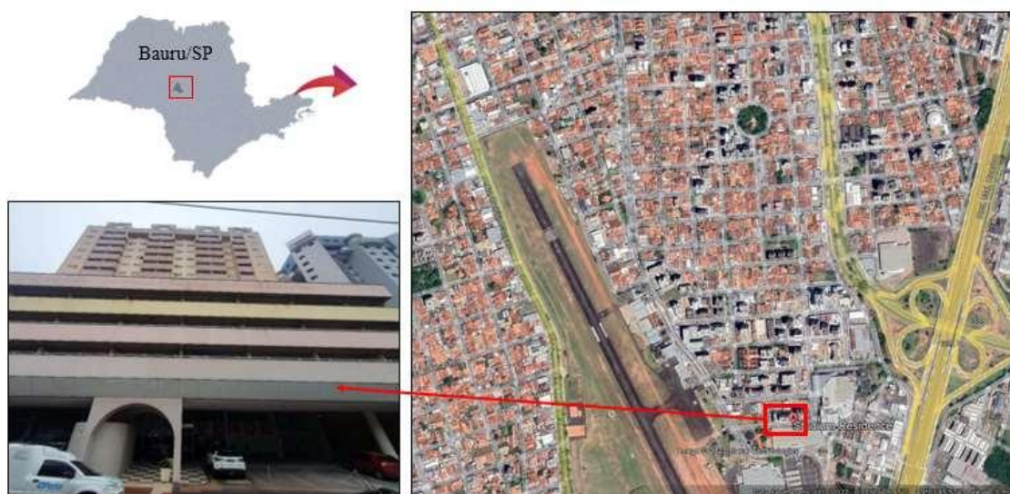
Figura 1 – Foto aérea do imóvel objeto de avaliação e o croqui de sua localização na cidade de Bauru/SP (Fonte: Google Earth 25/01/2023).
