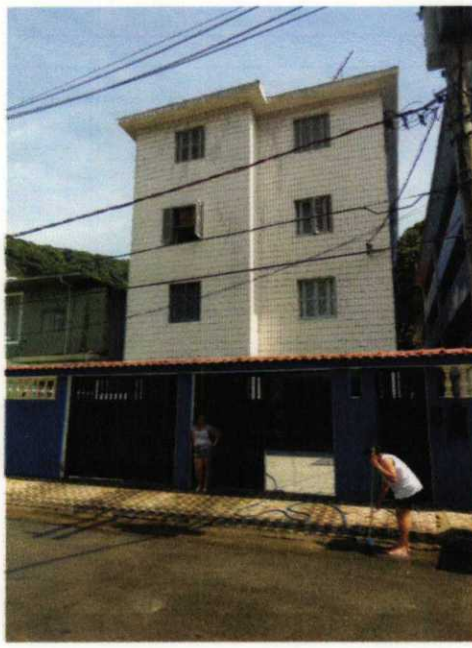
Fotos 3 a 5 – Vista do Edifício Imperador.
