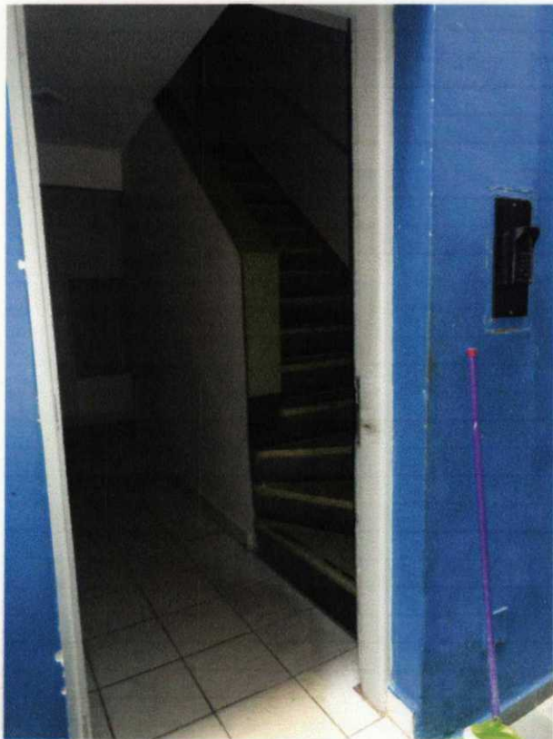
Foto 9 – Vista da entrada para os apartamentos.
