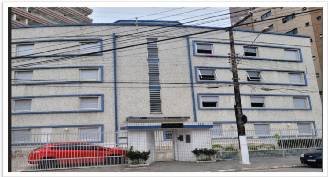
FOTO Nº 03 Vista parcial Fachada Condomínio Edifício Buenos Aires
