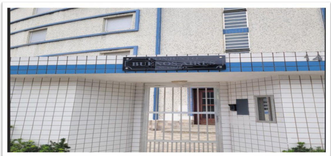
FOTO Nº 04 Vista parcial Fachada Condomínio Edifício Buenos Aires
