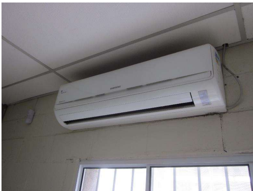
ITEM: 1,025 – AR-CONDICIONADO SPLIT, SAMSUNG, CAP. 24.000 BTUS
