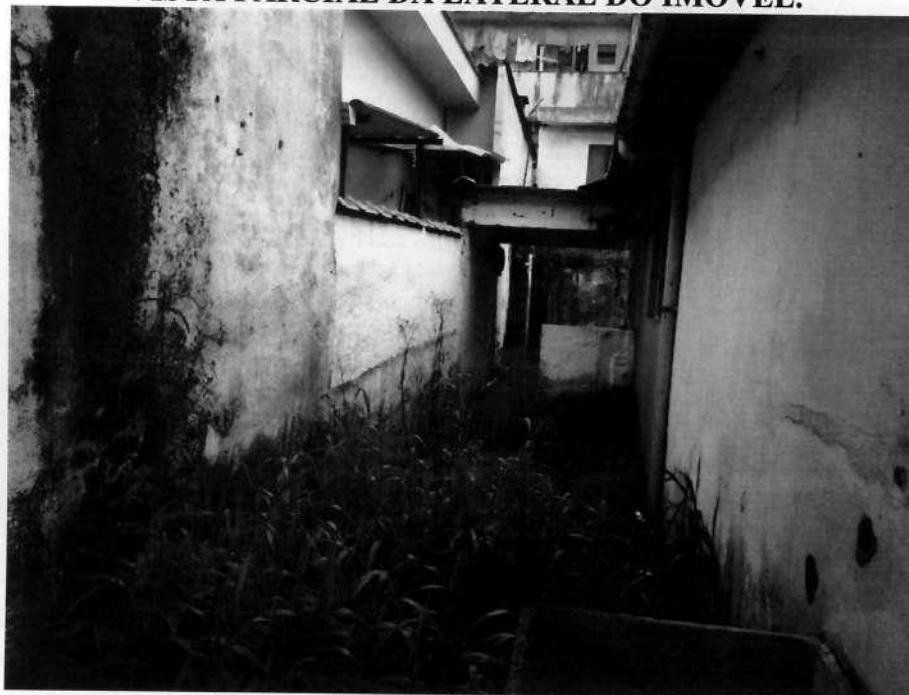
VISTA PARCIAL DA LATERAL DO IMÓVEL.
