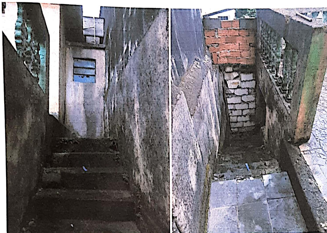
ESCADA DE ACESSO
