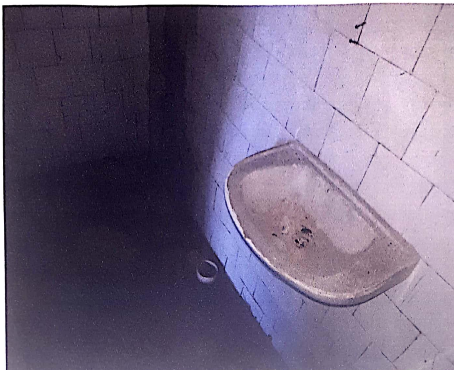
BANHEIRO DA GARAGEM
