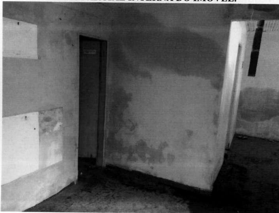
VISTA PARCIAL INTERNA DO IMÓVEL.
