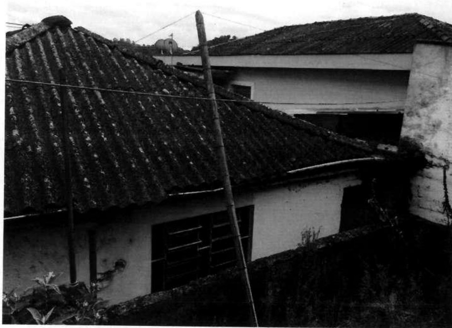
VISTA PARCIAL DA PORÇÃO TRASEIRA DO IMÓVEL.
