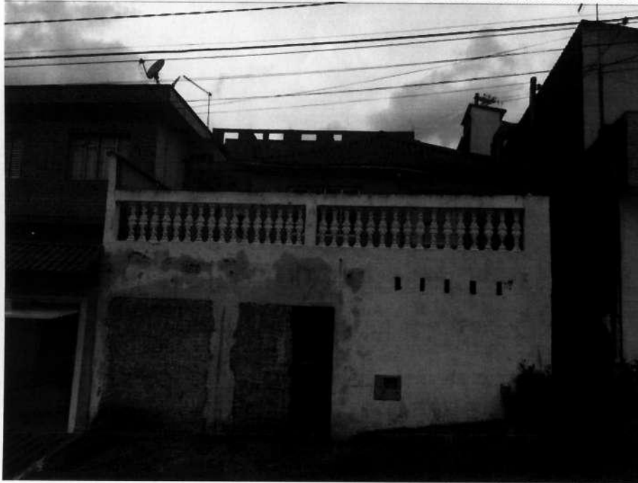
VISTA PARCIAL DA FACHADA DO IMÓVEL AVALIANDO.
