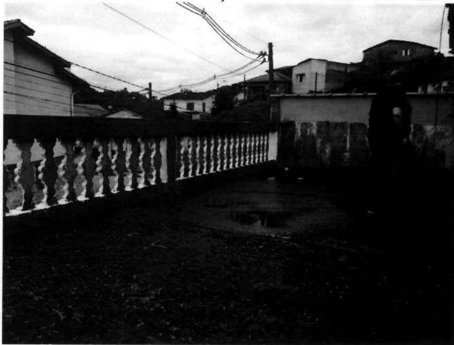
VISTA PARCIAL DA PORÇÃO FRONTAL DO IMÓVEL.
