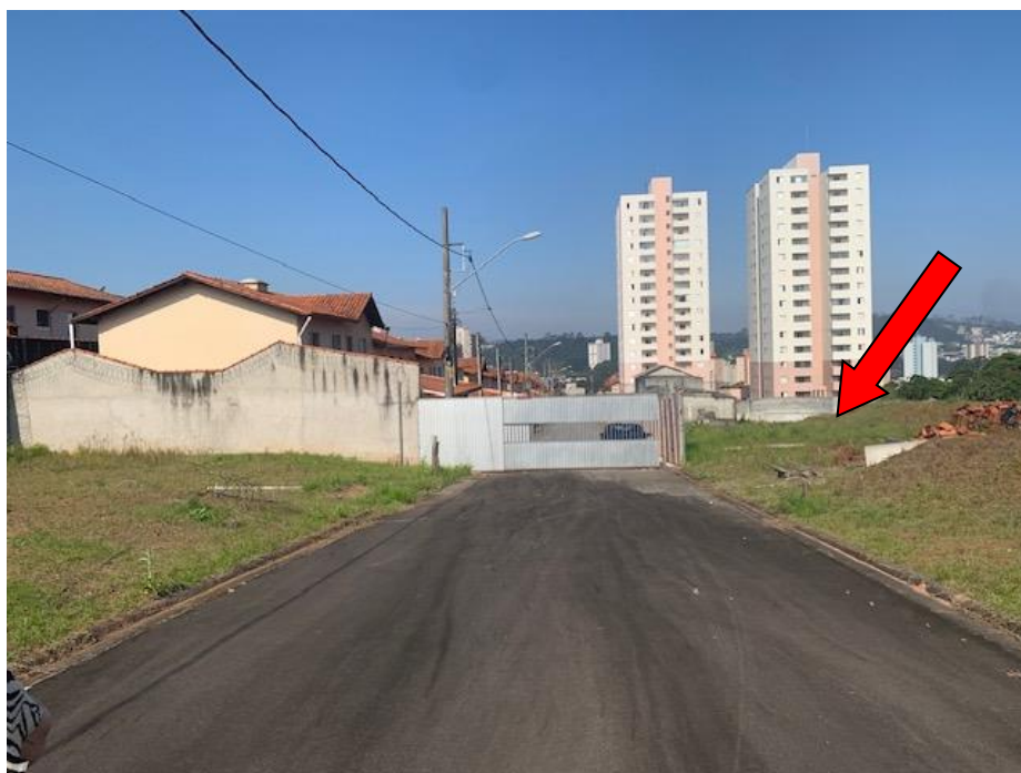
FOTO N. 10 : Fundo do terreno do Condomínio, vendo-se a porção de terreno, onde estão localizadas as unidades avaliandas.
