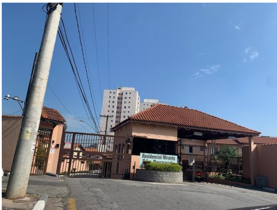
FOTO N. 02 : Entrada do Condomínio em maior aproximação.
