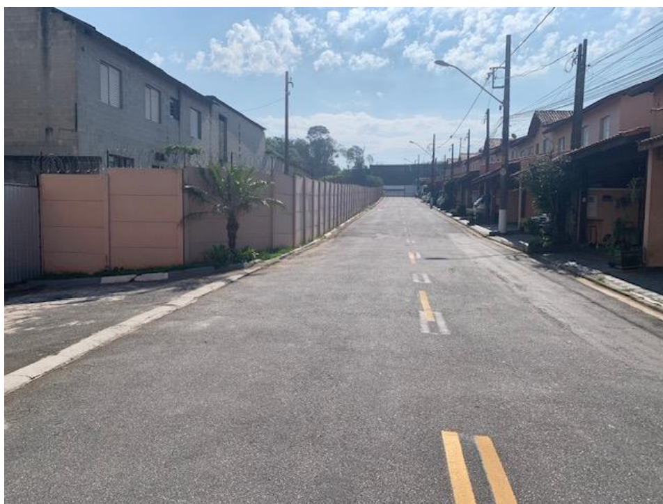
FOTO N. 03 : Vista interna do Condomínio.
