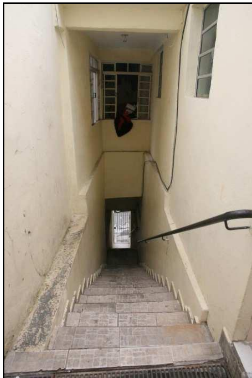
FOTOS 21/22/23 - Corredor de circulação do conjunto de casas.
