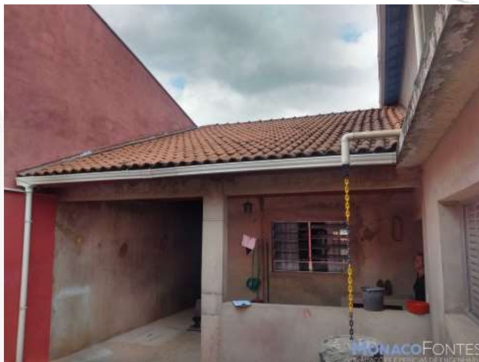
Acima tem-se a cobertura, onde nota-se suas dimensões e acabamentos.
