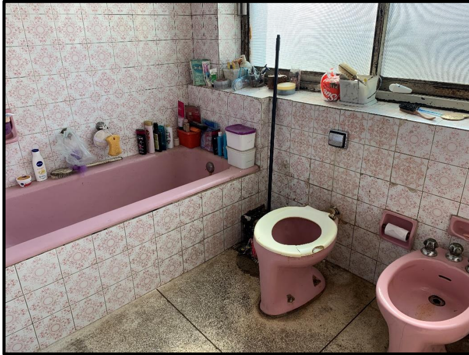
Figura 31 – Detalhe do banheiro
