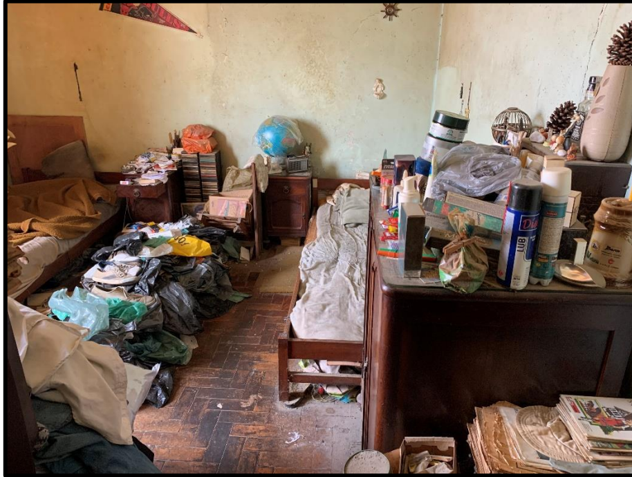
Figura 25 – Detalhe do dormitório
