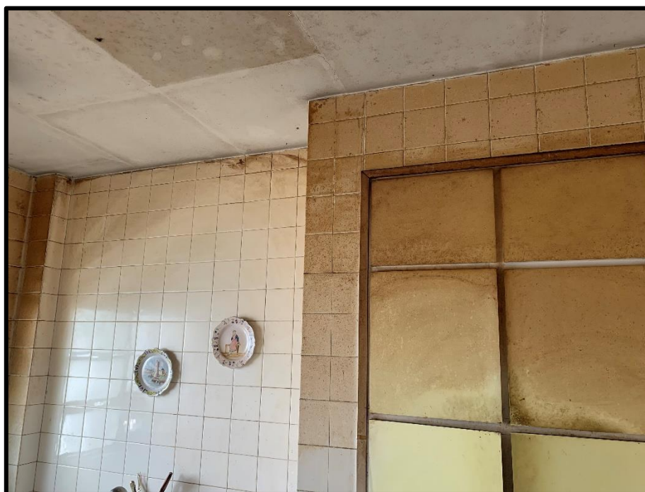
Figura 18 – Cozinha com detalhe das paredes
