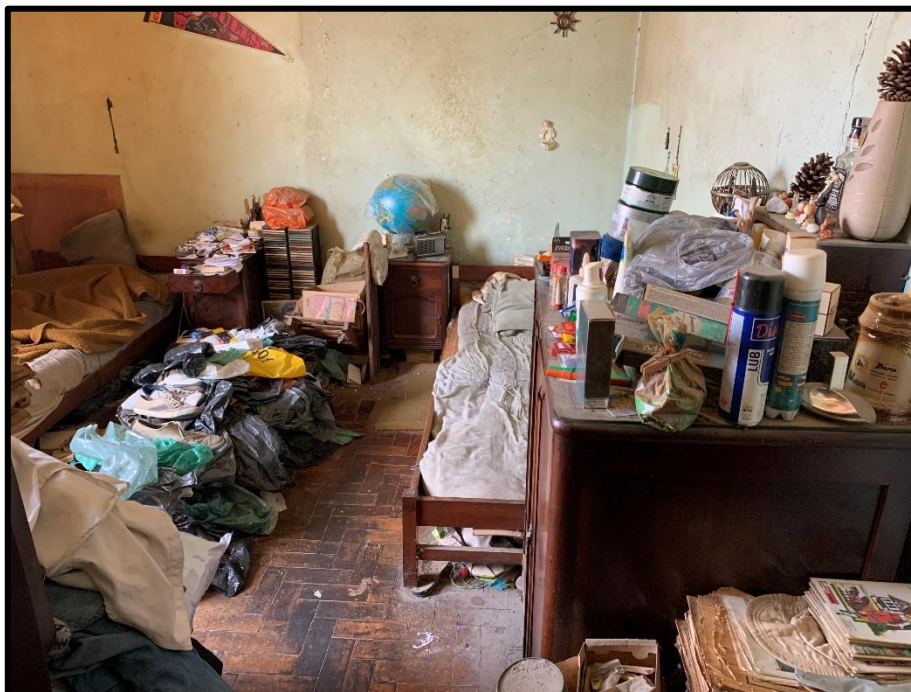
Figura 35 – Detalhe do dormitório
