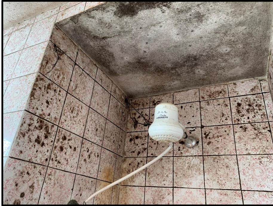
Figura 33 – Detalhe do banheiro
