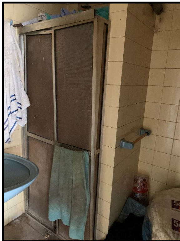
Figura 24 – – Detalhe do banheiro
