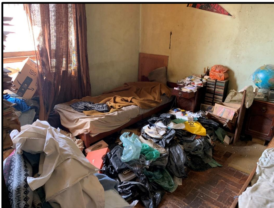
Figura 26 – Detalhe do dormitório
