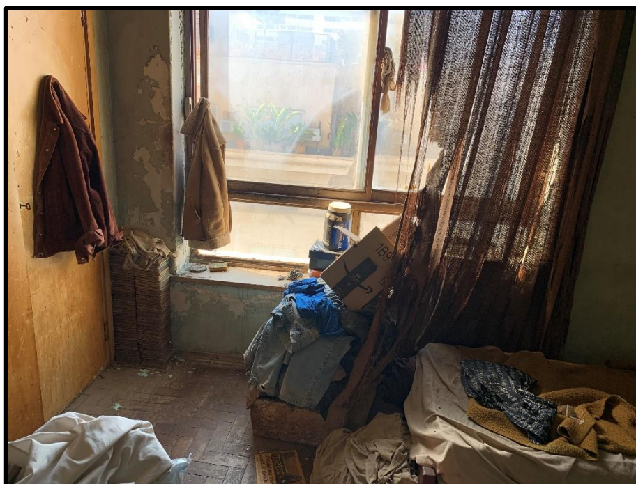
Figura 30 – Detalhe do dormitório
