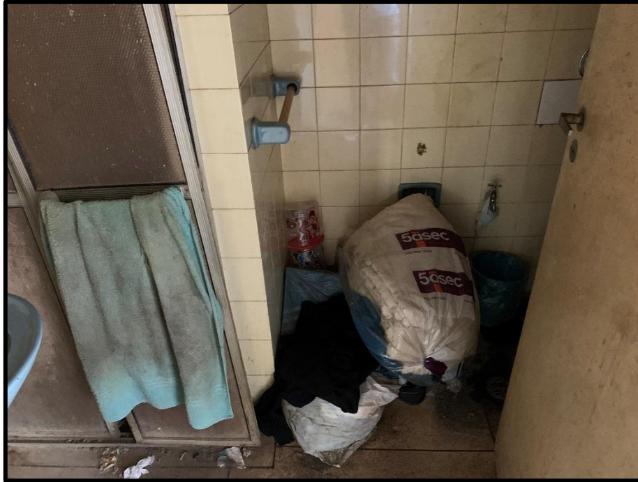
Figura 23 – Detalhe do banheiro
