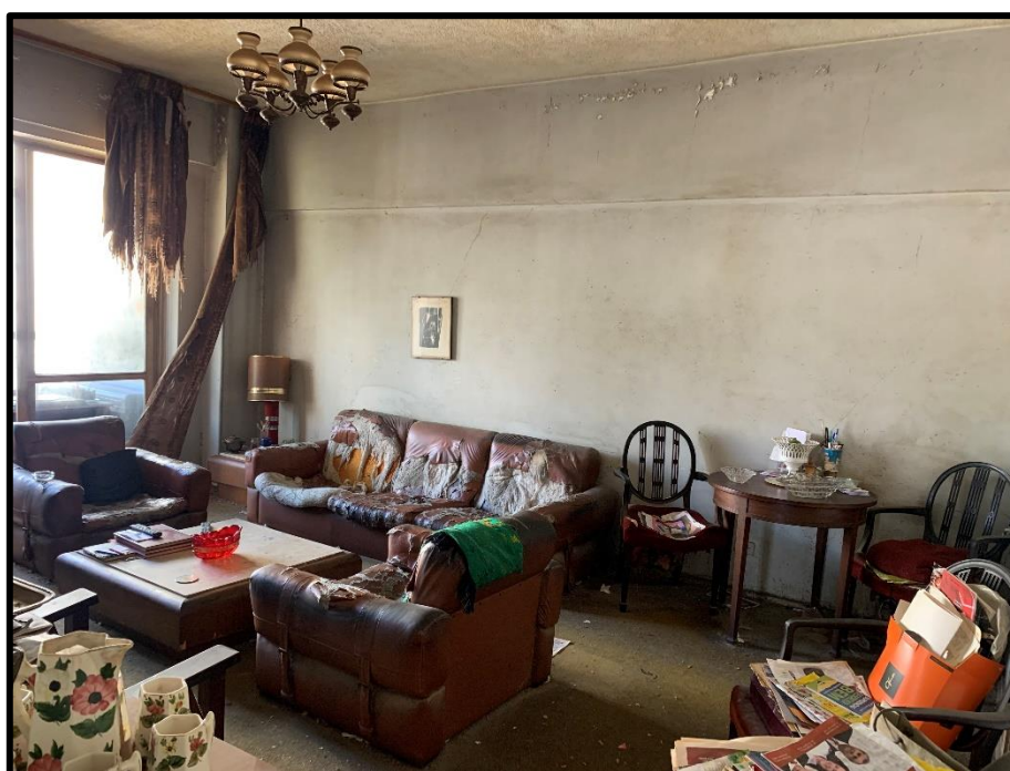
Figura 06 – Sala com detalhe das paredes
