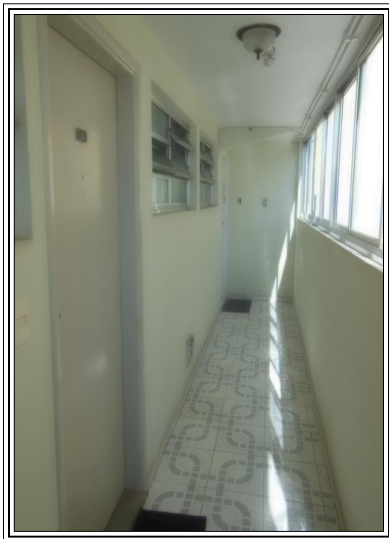
FOTO 23 : Outro ângulo do corredor social de acesso às unidades do 5º andar do Bloco B do Edifício Panorama.
