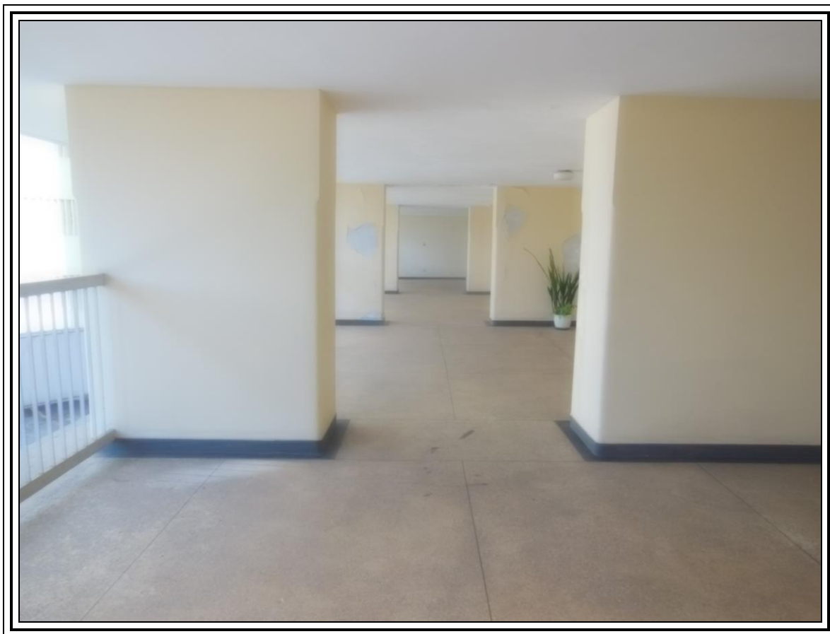
FOTO 19 : Outro ângulo da área coberta sem função existente no Edifício Panorama.
