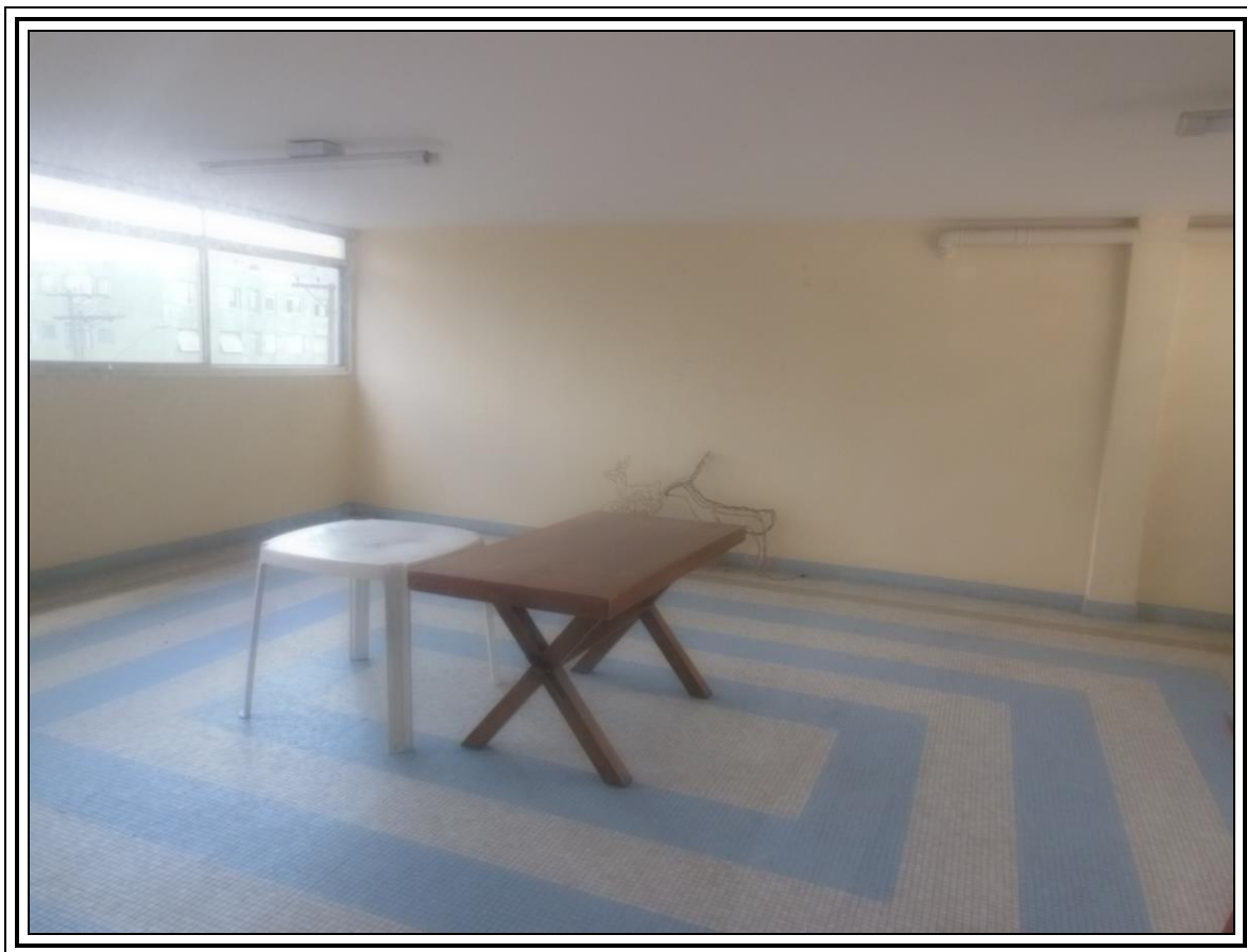
FOTO 11 : Vista parcial da pequena sala fechada, existente junto ao salão de festas do Edifício Panorama.
