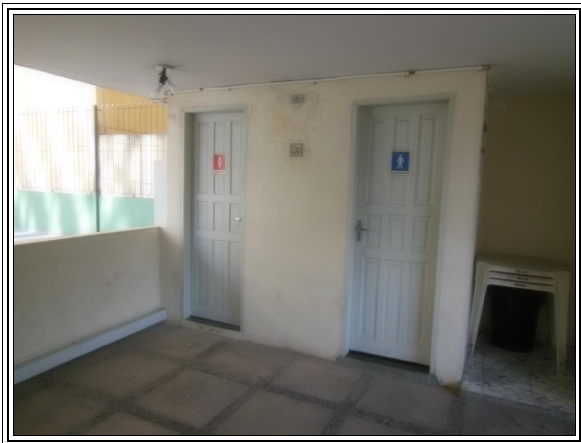
FOTO 14 : Detalhe dos banheiros do salão de festas, notando-se que a lateral é aberta, voltada para o pátio interno descoberto.
