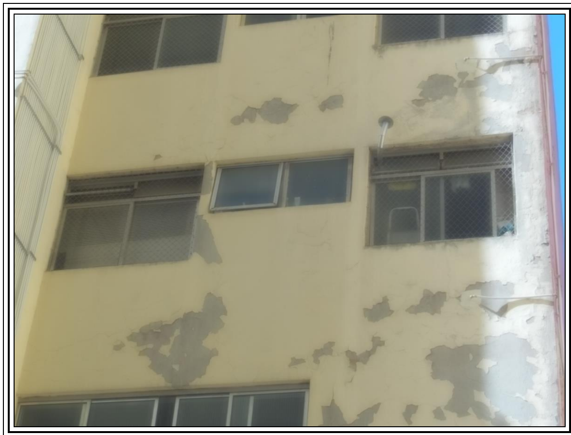
FOTO 27 : Ângulo mais aproximada da localização da unidade nº 505, na fachada do Bloco B do Edifício Panorama.
