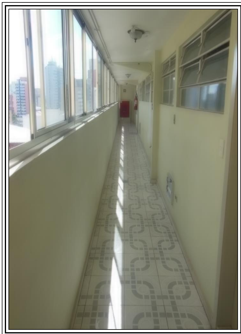
FOTO 22 : Vista parcial do corredor social de acesso às unidades do 5º andar do Bloco B do Edifício Panorama.
