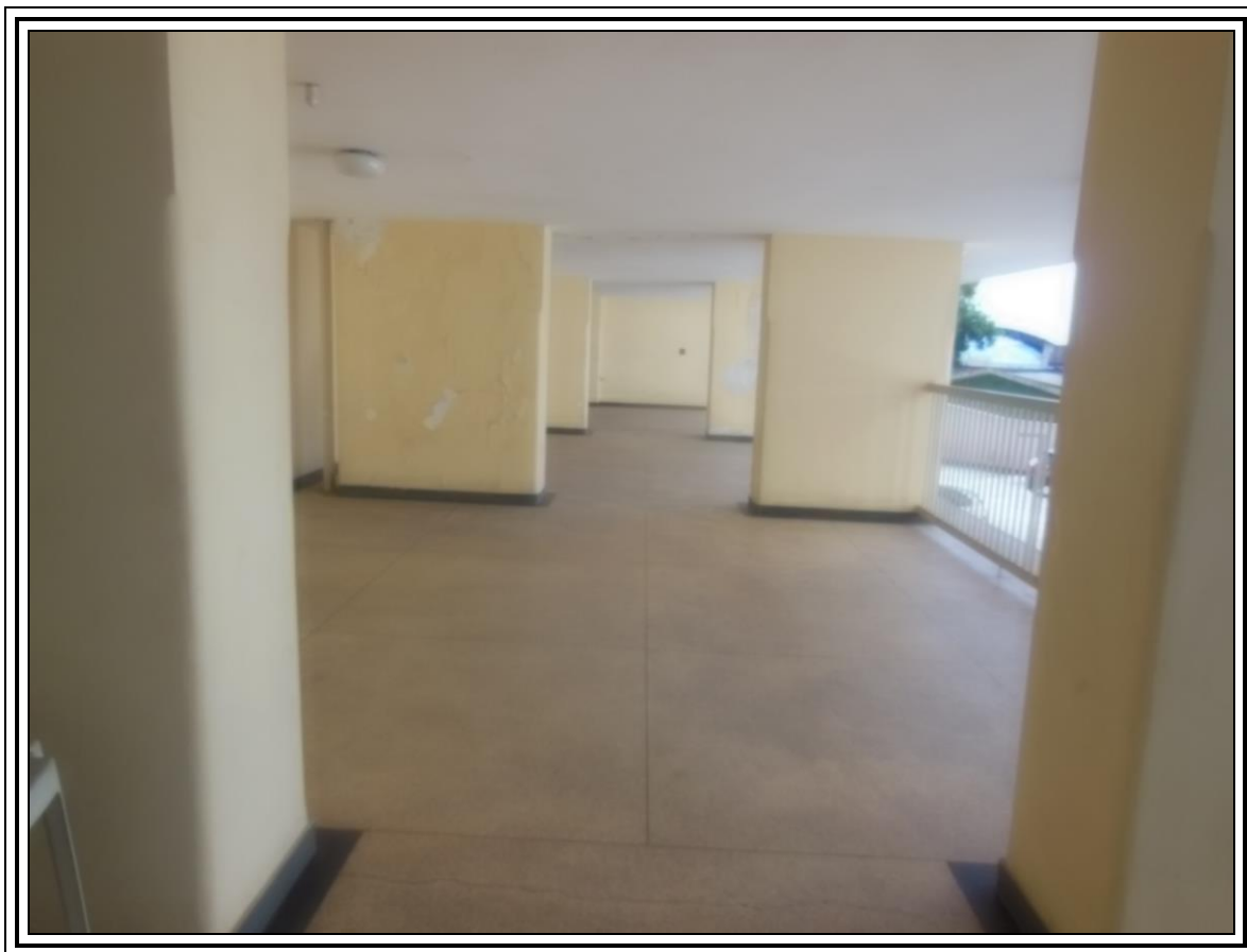
FOTO 18 : Detalhe da área coberta sem função existente no Edifício Panorama.
