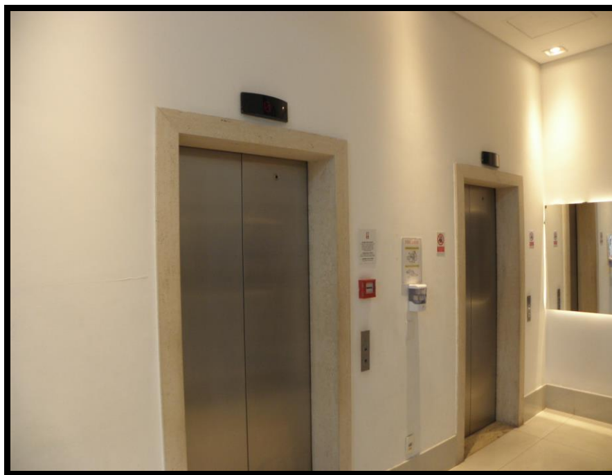
Aspecto dos elevadores
