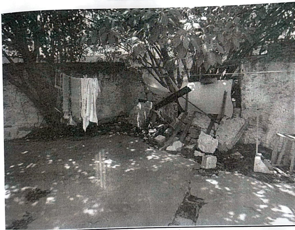
Fotos 10: área de serviço.
