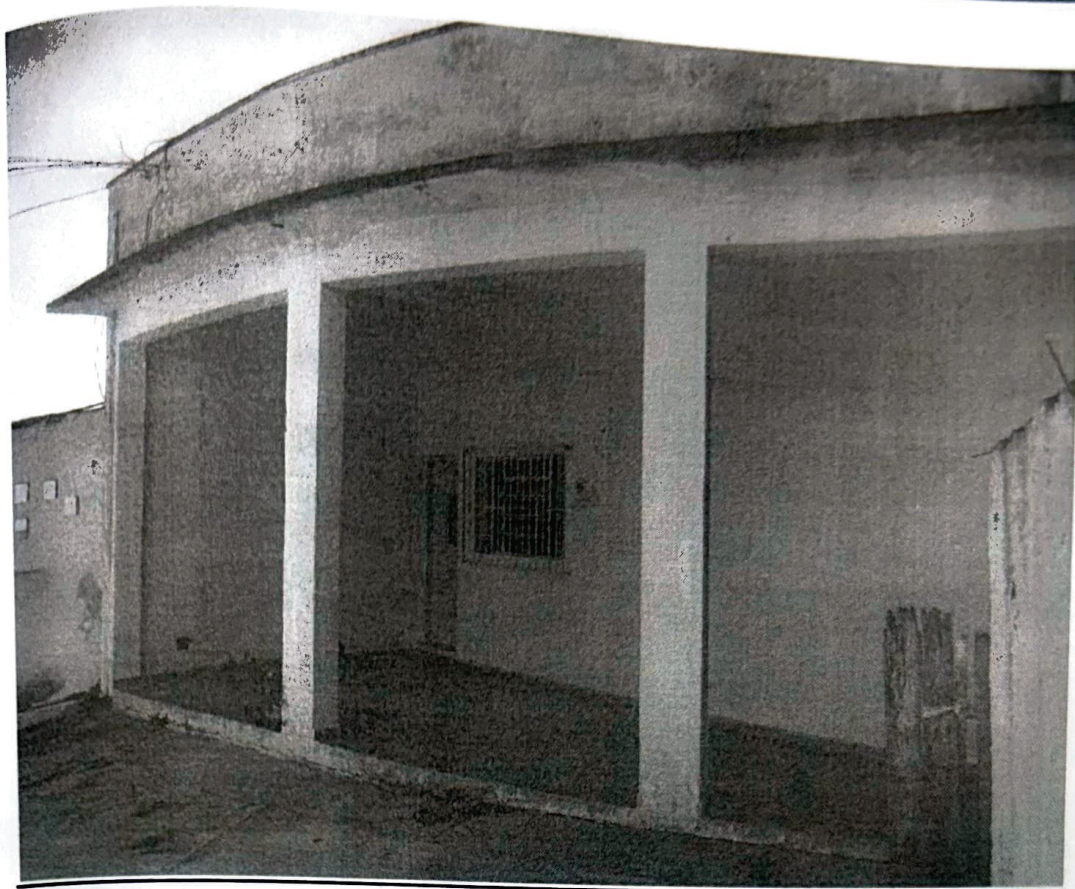
Foto 2: Fachada do imóvel.
