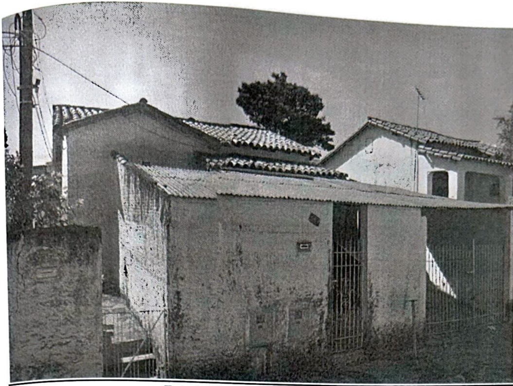
Foto 1: Vista externa do imóvel.
