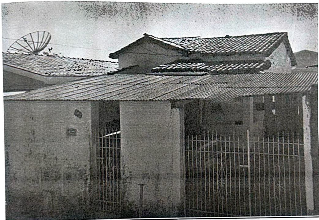
Foto 2: Vista externa do imóvel (ângulo oposto).
