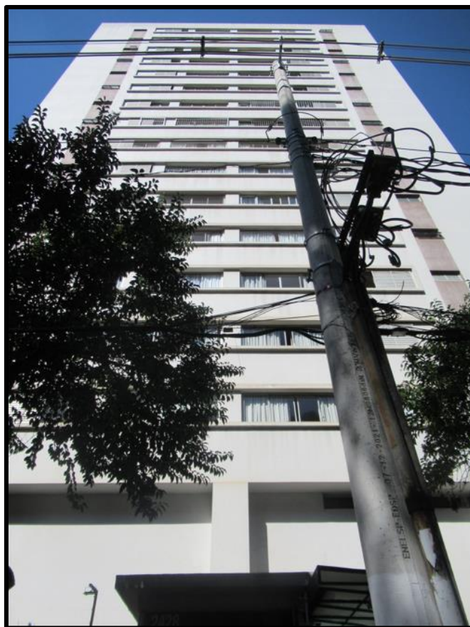
Foto 1: Condomínio Edifício Camboriú
