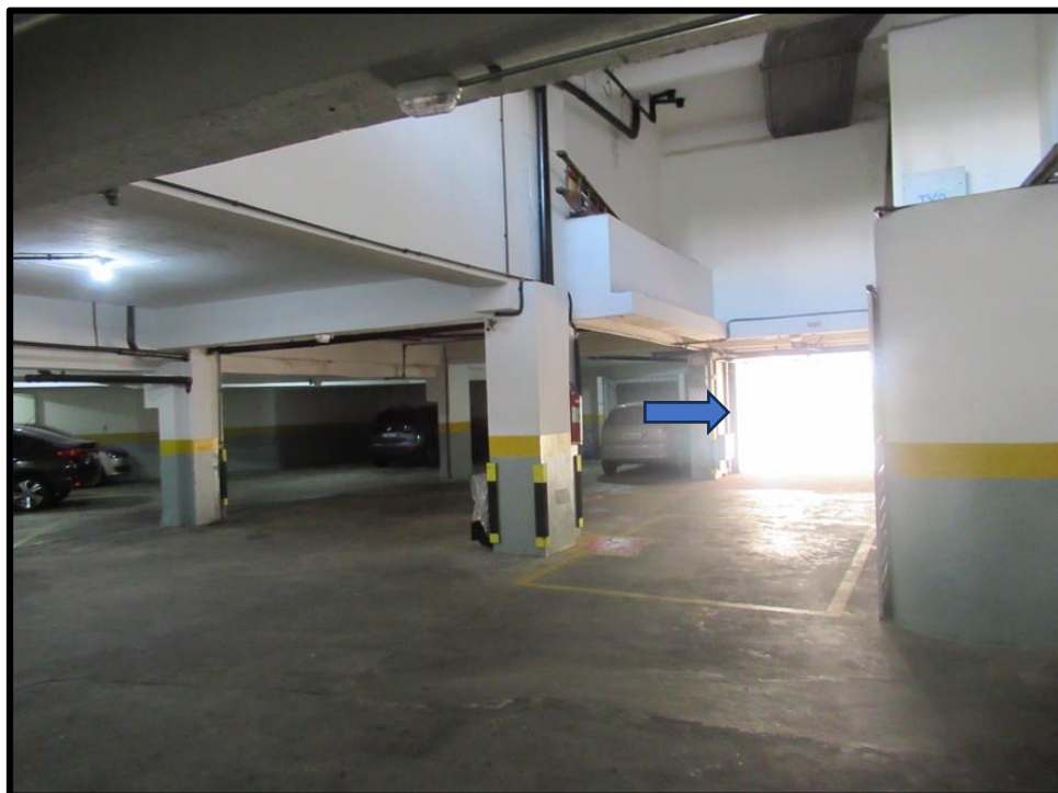
Foto 7: Entrada da garagem
