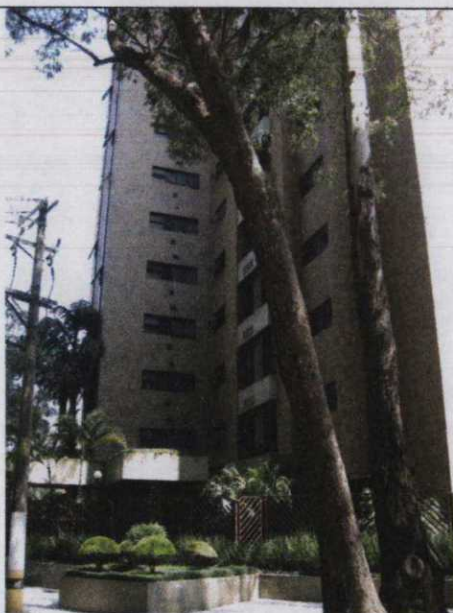
Foto 01 – Vista da fachada de frente do edifício Esplanada Morumbi
