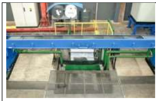
Figura 08 – Resfriador do tubo após Soldagem
