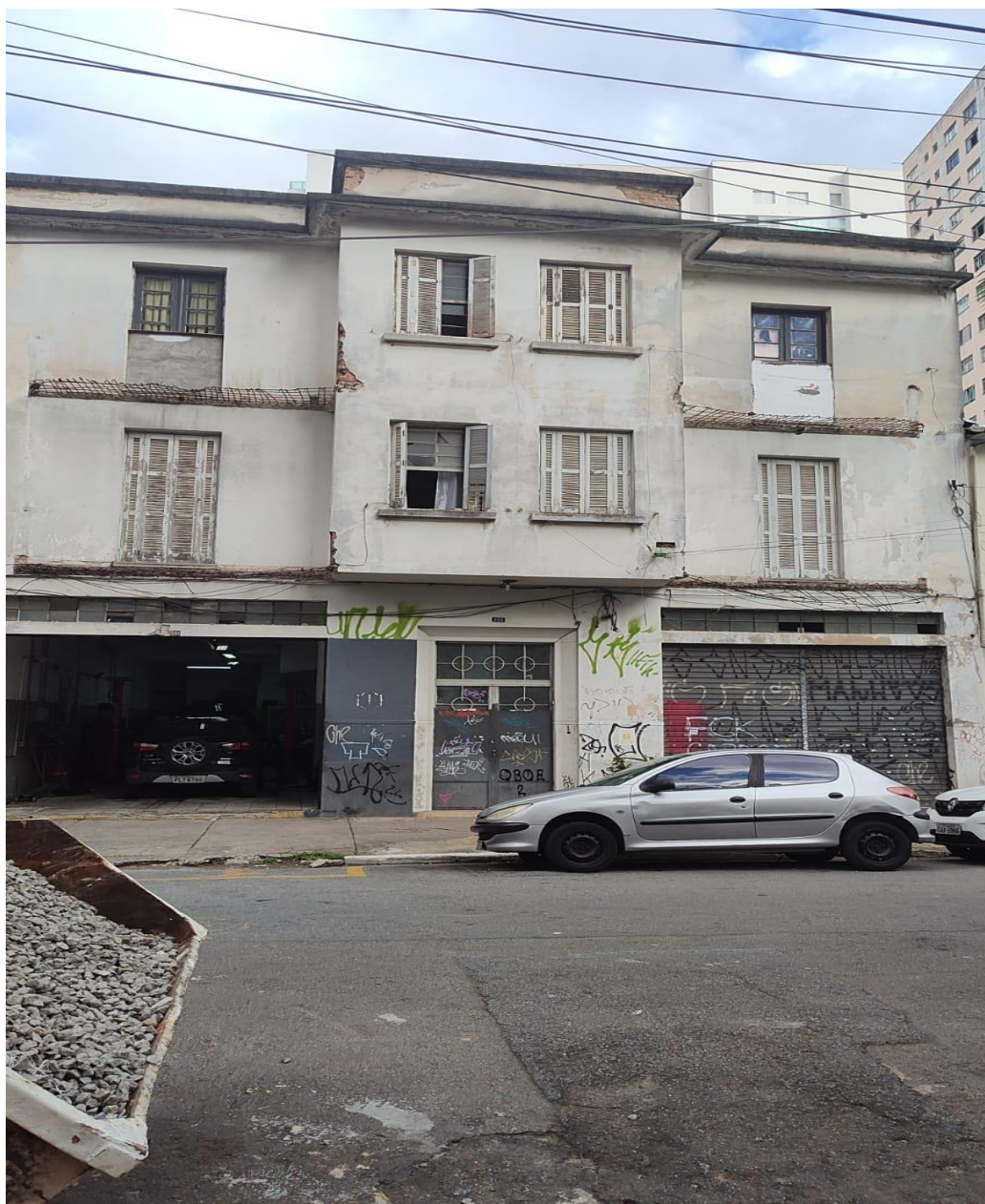
Foto 55 – Fachada do sobrado
