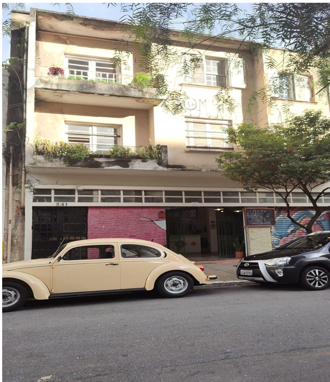
Foto 52 – Fachada do sobrado
