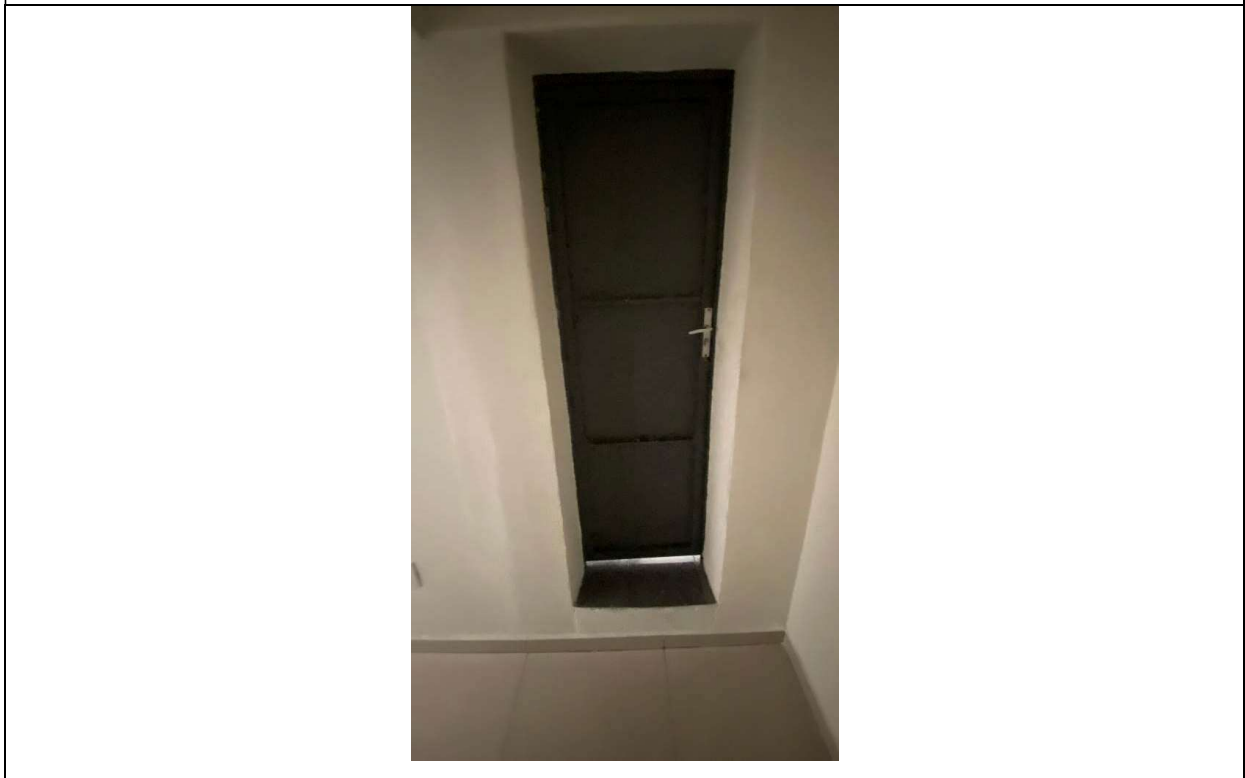
ACESSO AO TELHADO, PARA MANUTENÇÃO.
