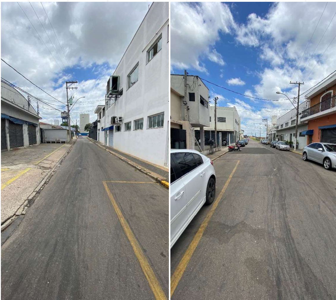
VISTAS DA TRAVESSA GIACOMO ARMELIN, NO TRECHO ONDE SE SITUA O IMÓVEL AVALIANDO.
