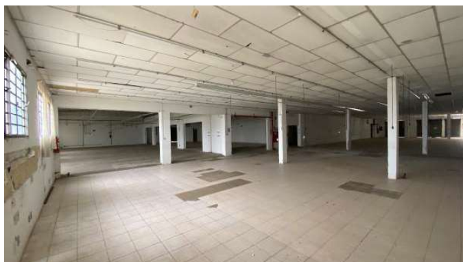
MAIS VISTAS DO GALPÃO, NA PARTE DOS FUNDOS, ERIGIDA SOBRE O TERRENO DO IMÓVEL VIII (M. 39.648, DO 1º C.R.I. DE CAPIVARI).
