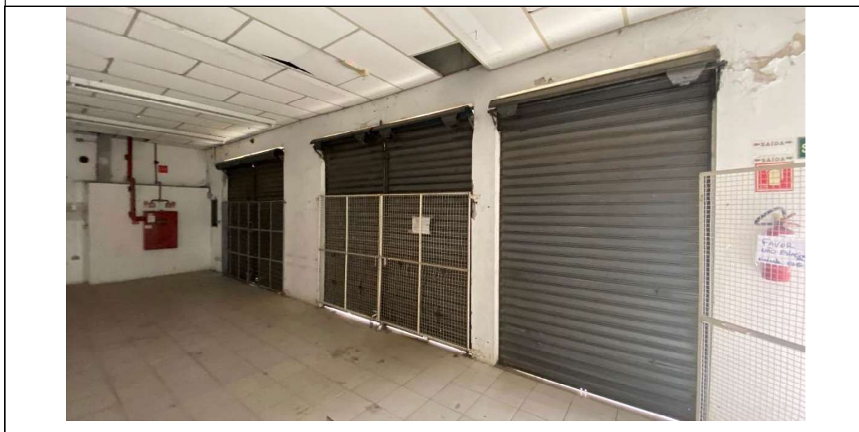
PORTAS DE ENTRADA DO GALPÃO.
