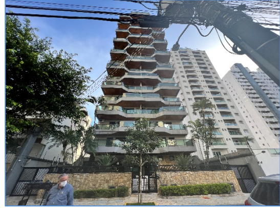
Foto 10 – Vista da fachada frontal
