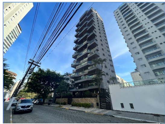
Foto 12 – Vista do Edifício Fernanda I
