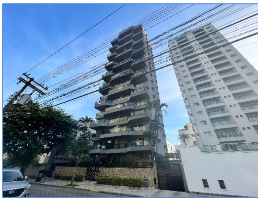
Foto 11 – Vista do Edifício Fernanda I
