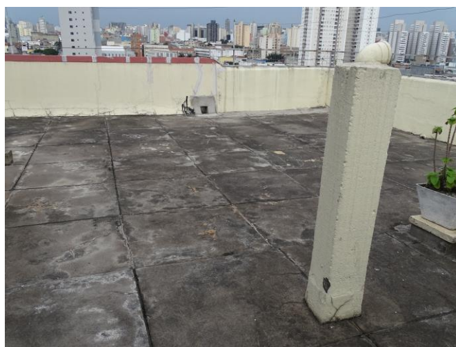
ÁREA COMUM DO TERRAÇO NO PAVIMENTO COBERTURA.
