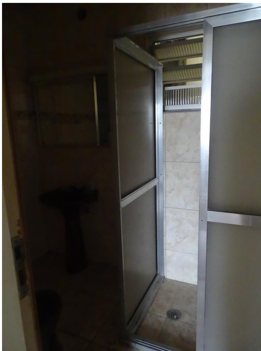
ASPECTO CARACTERISTICA DO BANHEIRO .
