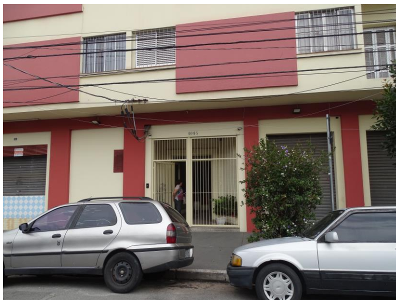
ENTRADA PARA O BLOCO DO PRÉDIO DE APARTAMENTOS.
