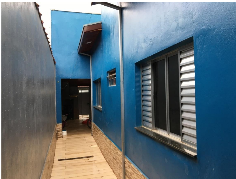
Foto 30 – Corredor lateral de acesso – edícula/área de lazer
