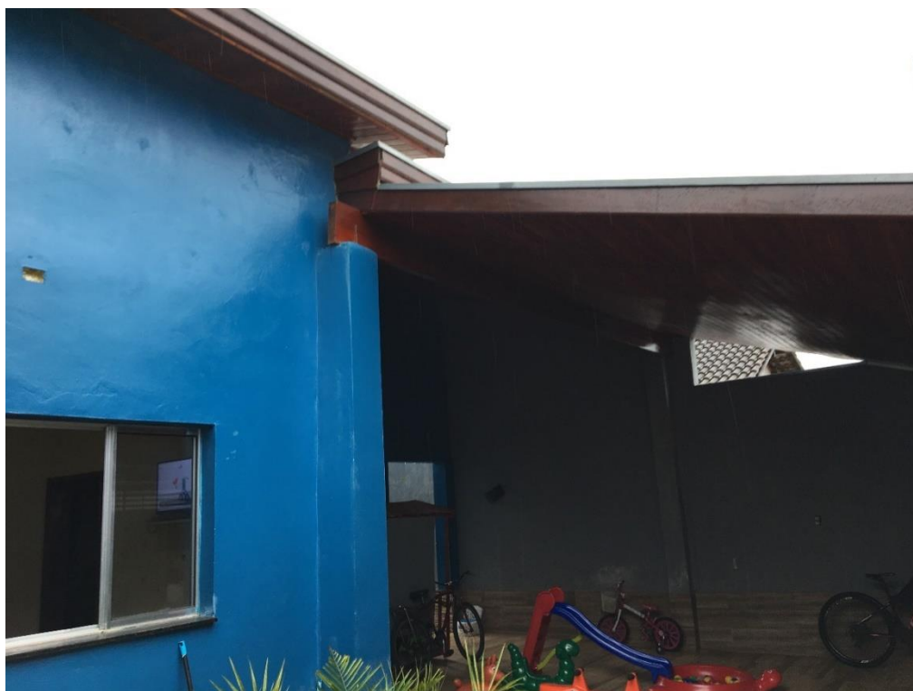
Foto 6 – Vista à partir do jardim para a garagem
