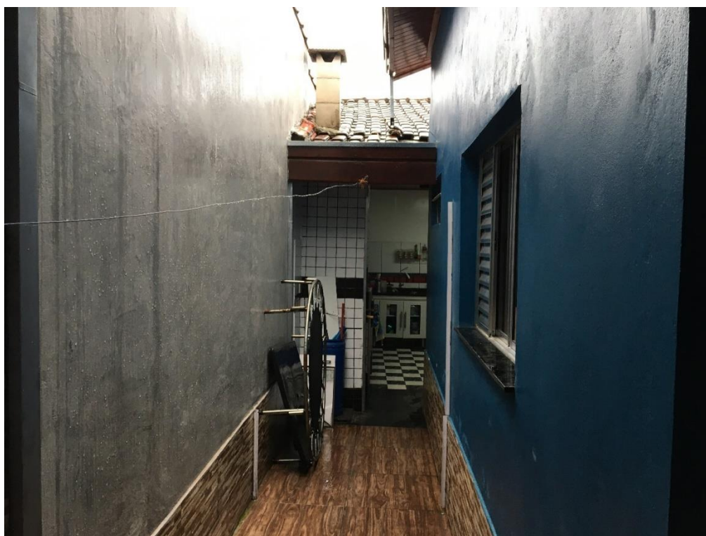
Foto 21 – Corredor lateral/ acesso edícula - área de lazer
