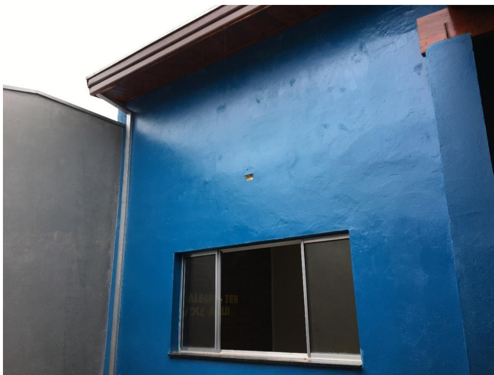
Foto 5 – Vista à partir do jardim para janela da sala
