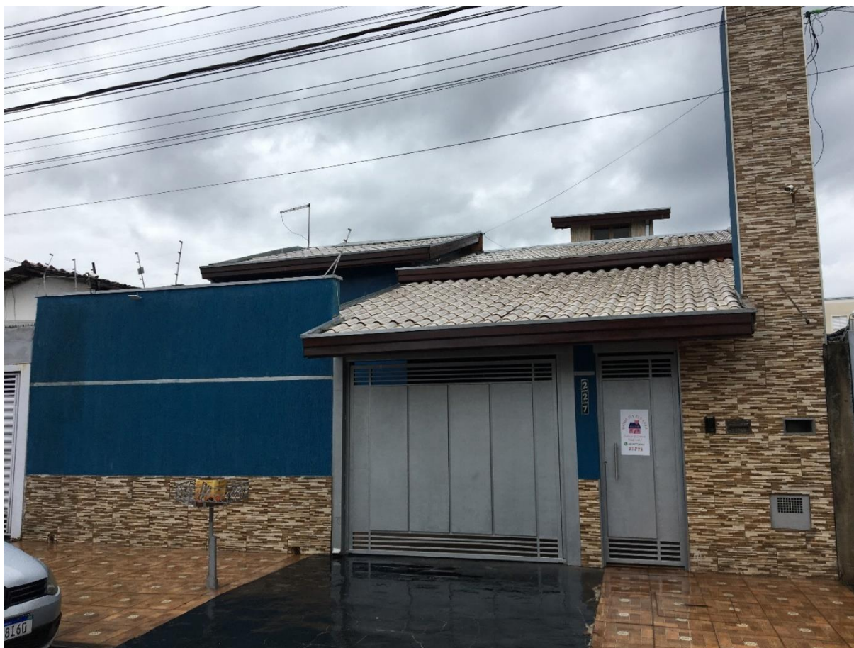
Foto 1 – Vista da Fachada do imóvel – Rua Carleto Domingues
