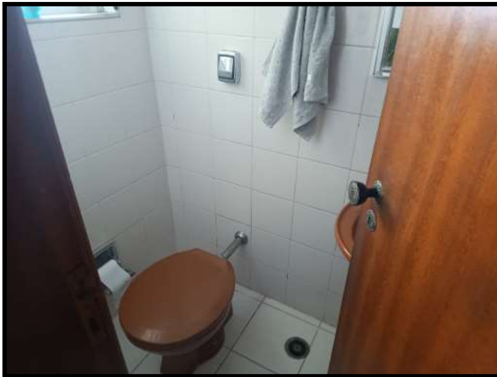
VISTA DO LAVABO NO PAVIMENTO TÉRREO
