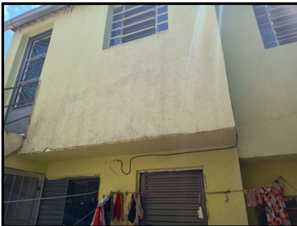
VISTA DA EDÍCULA LOCALIZADA NOS FUNDOS DO IMÓVEL
