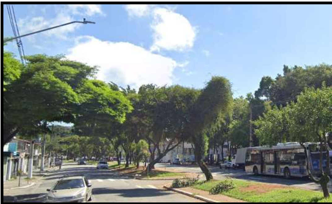
VISTA LONGITUDINAL OPOSTA DA AVENIDA ANTÔNIO CESAR NETO
