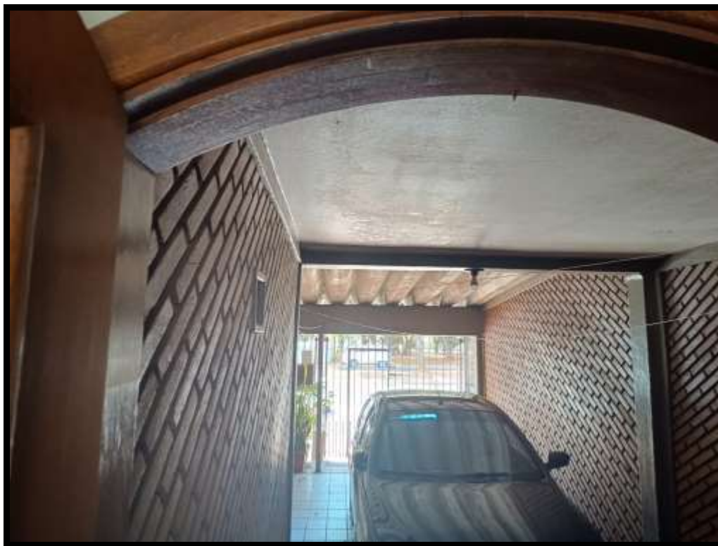
VISTA DA ENTRADA DO LADO OPOSTO
