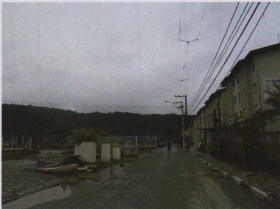
FOTO 04:- Vista do logradouro que finda no condomínio fechado e lado esquerdo da Gleba A5 e mais a esquerda a Gleba A5B objeto de pericia.
