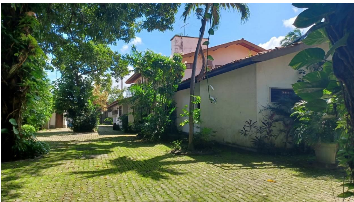
Vista do imóvel
