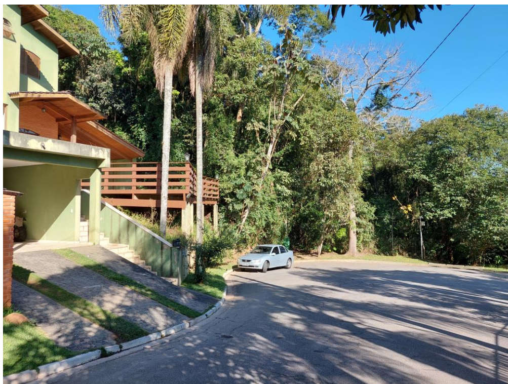
Vista do final da rua, onde se localiza o imóvel avaliando.
