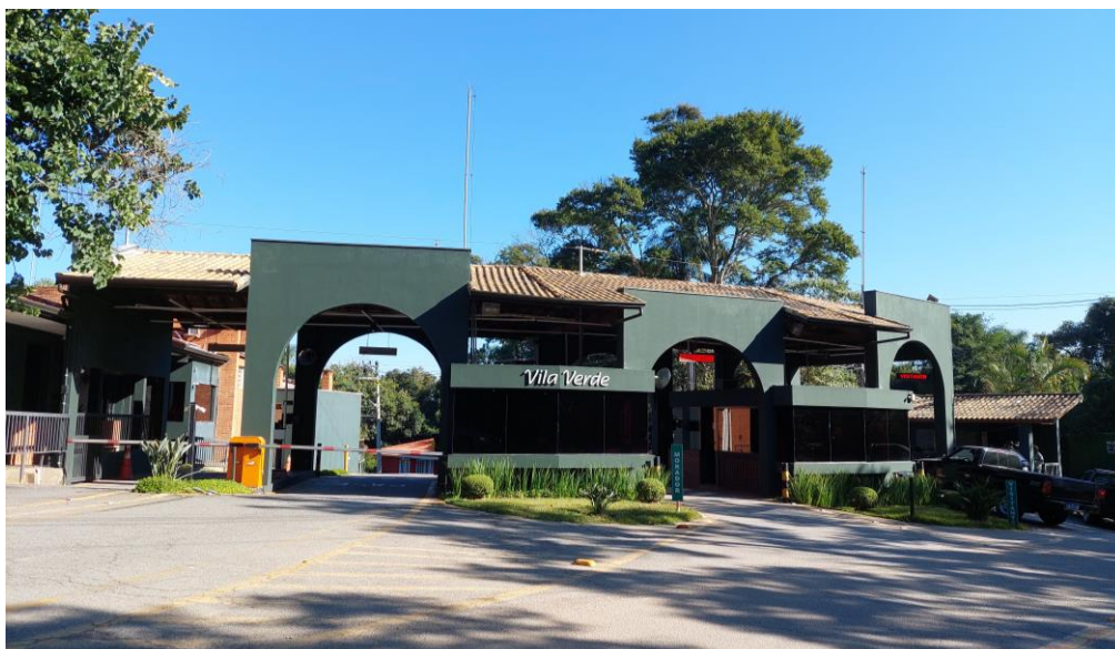
Vista da entrada do Condomínio Vila Verde, onde se localiza o imóvel avaliando.
