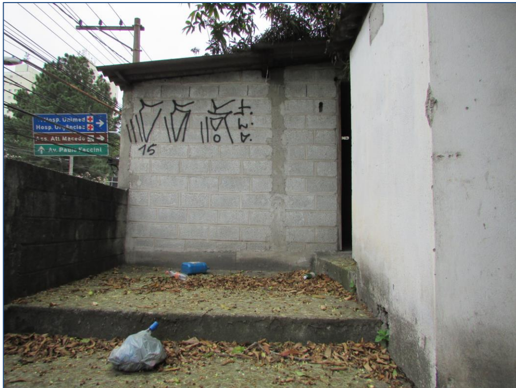
ASPECTOS DA EDIFICAÇÃO.
