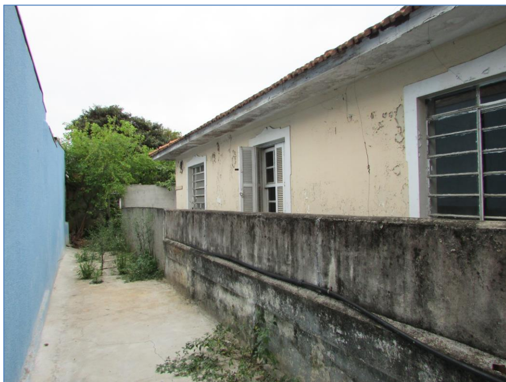
ASPECTOS DA EDIFICAÇÃO.
