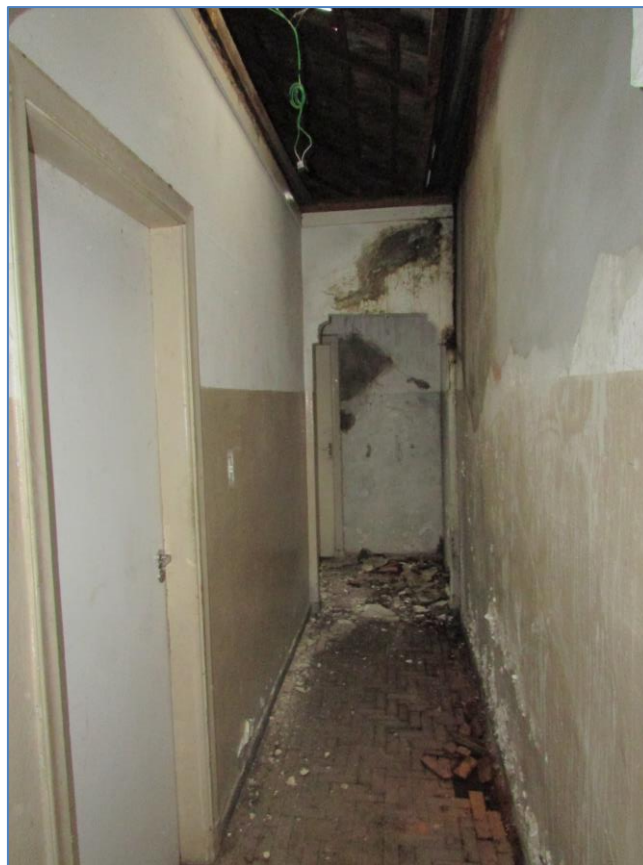
ASPECTOS DA EDIFICAÇÃO.
