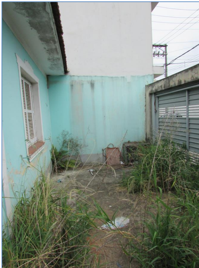
ASPECTOS DA EDIFICAÇÃO.
