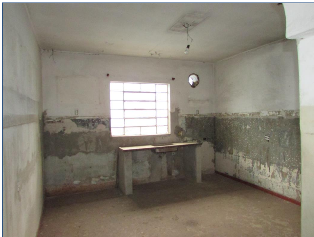
ASPECTOS DA EDIFICAÇÃO.
