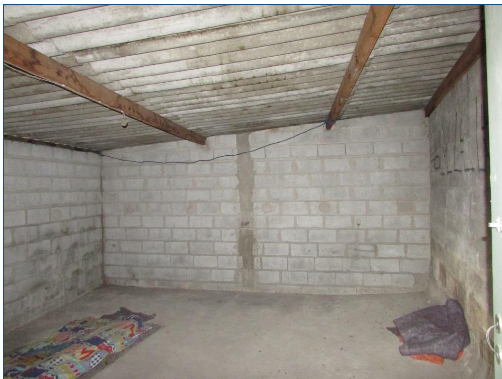
ASPECTOS DA EDIFICAÇÃO.
