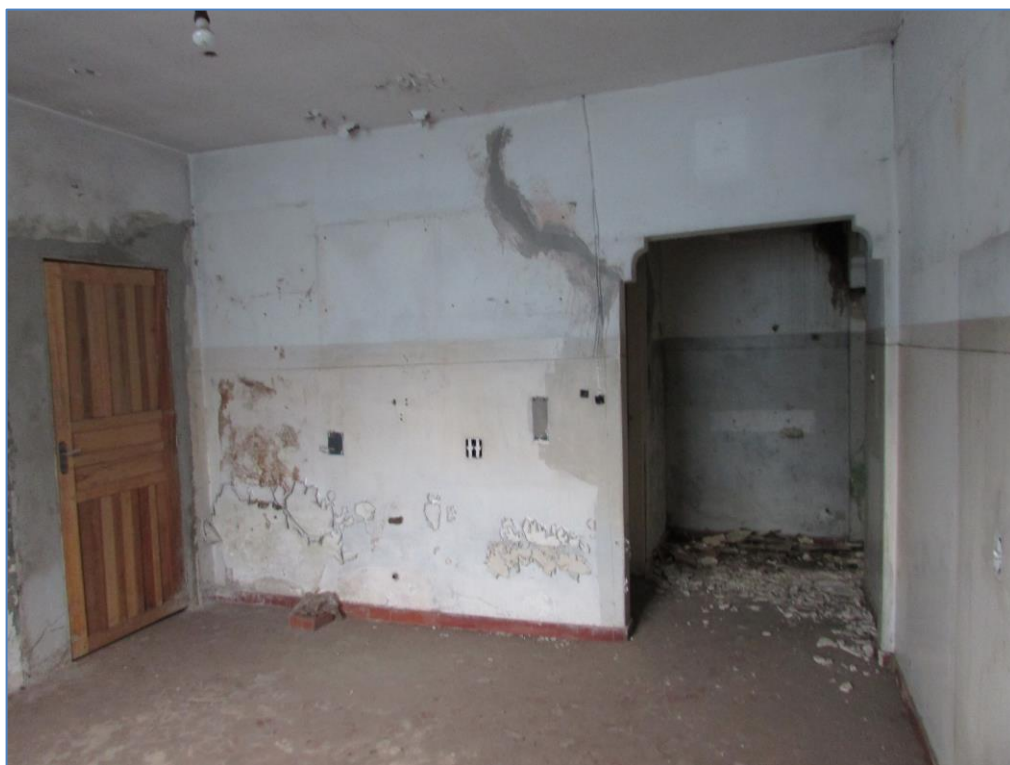
ASPECTOS DA EDIFICAÇÃO.
