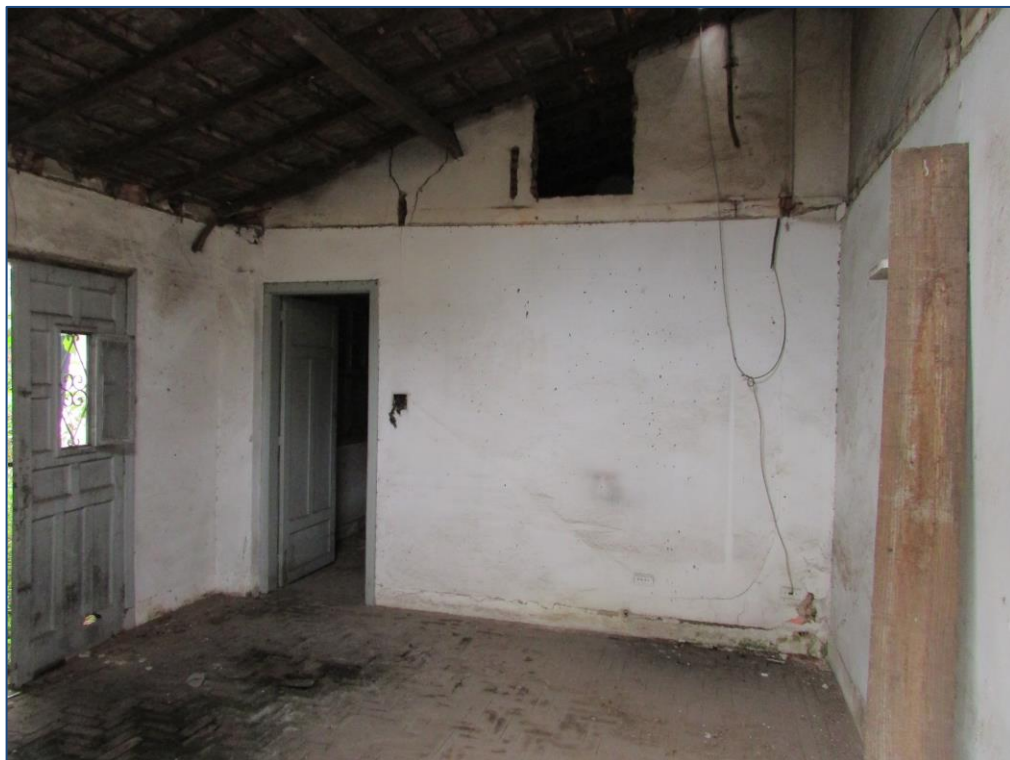
ASPECTOS DA EDIFICAÇÃO.
