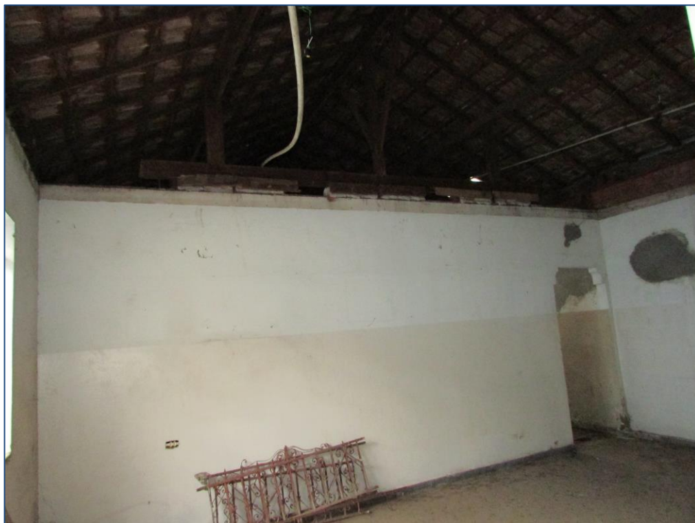
ASPECTOS DA EDIFICAÇÃO.
