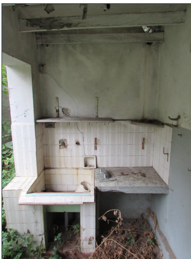
ASPECTOS DA EDIFICAÇÃO.
