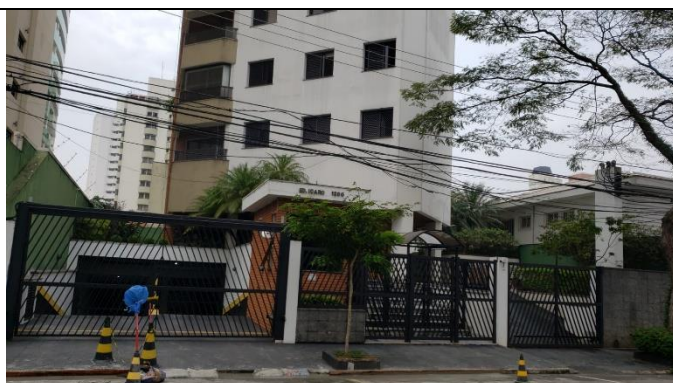
Foto 03 – Portaria e entrada do edifício Ícaro.
