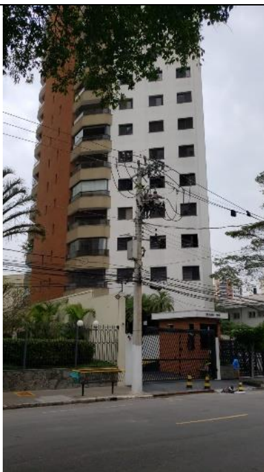
Foto 01 – Fachada principal do edifício Ícaro, sito à Rua Zacaria de Gois, 1.296.
