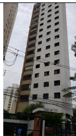
Foto 04 – Outra vista da fachada principal.
