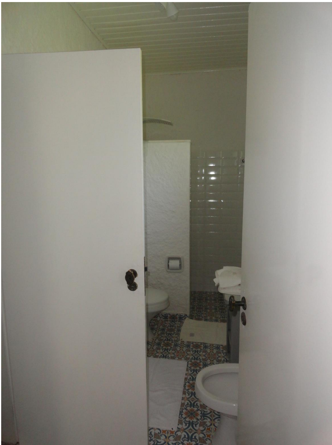
FOTO nº. 19 – 2.1.3.1. - RESIDÊNCIA PRINCIPAL DETALHE: Banheiro
