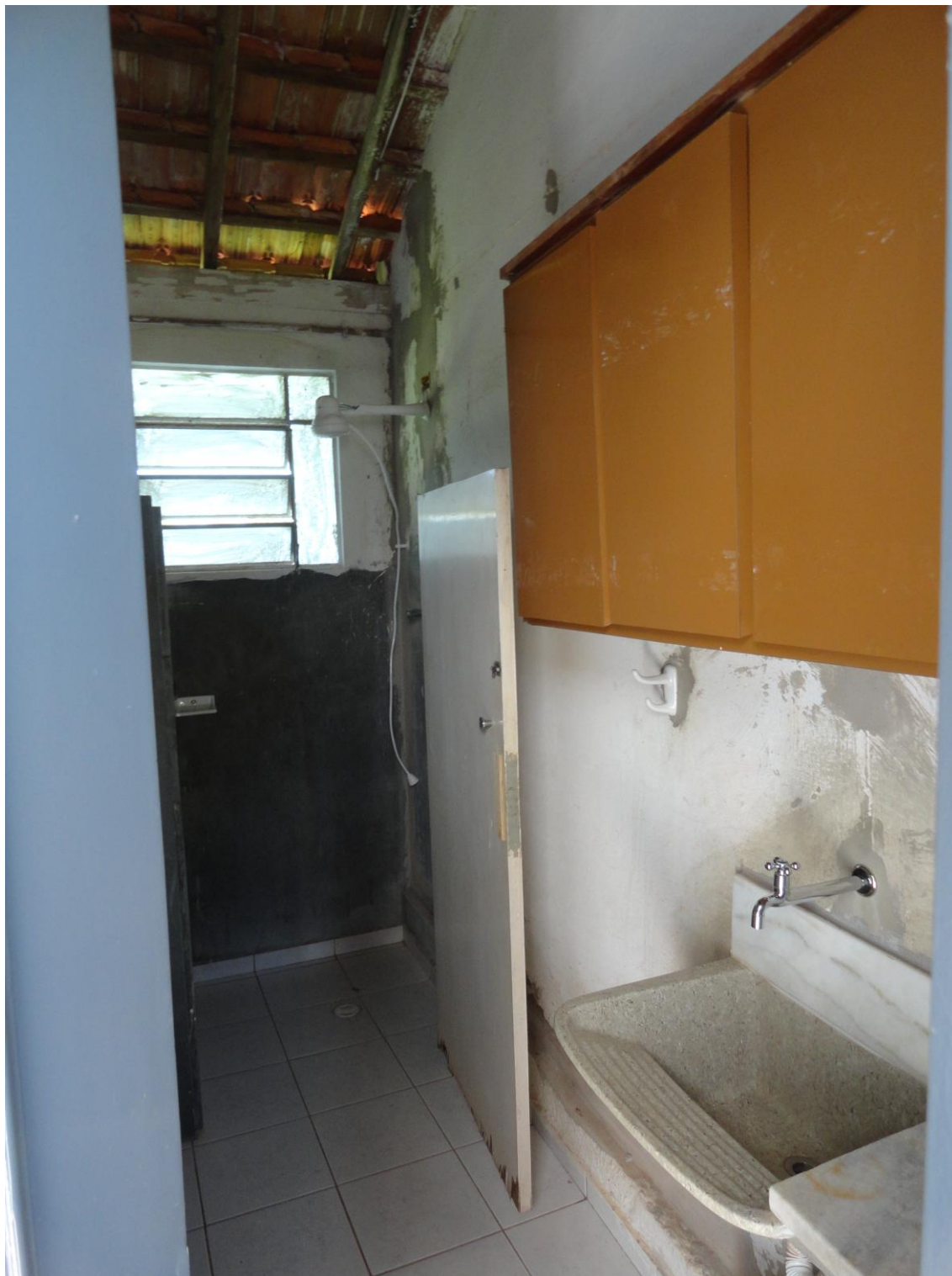
FOTO nº. 52 – 2.1.3.6. - DEPÓSITOS DETALHE: Vista interna.
