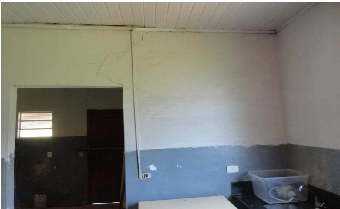
FOTO n.º 41 – 2.1.3.5. - RESIDÊNCIA CASEIRO DETALHE: Sala - vista interna.
