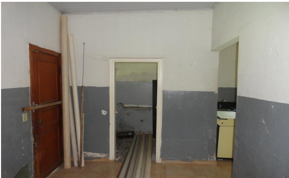
FOTO n.º 43 – 2.1.3.5. - RESIDÊNCIA CASEIRO DETALHE: Vista interna.
