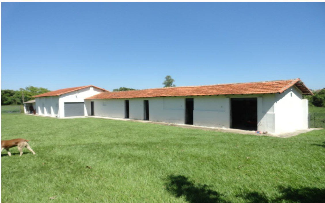
FOTO nº. 47 – 2.1.3.6. - DEPÓSITOS DETALHE: Fachada .
