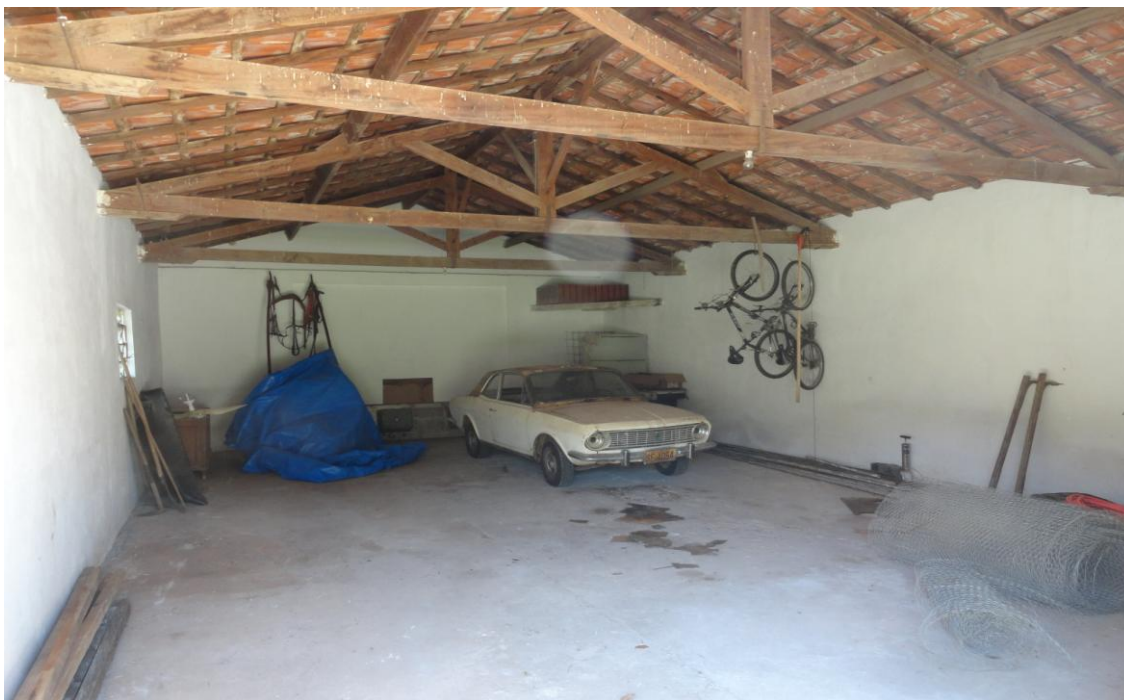
FOTO nº. 53 – 2.1.3.6. - DEPÓSITOS DETALHE: Vista interna.
