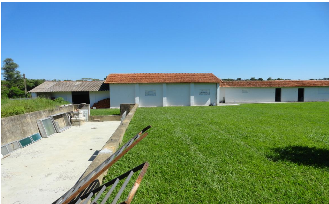
FOTO nº. 56 – 2.1.3.8. - DETALHE: Vista Geral.
