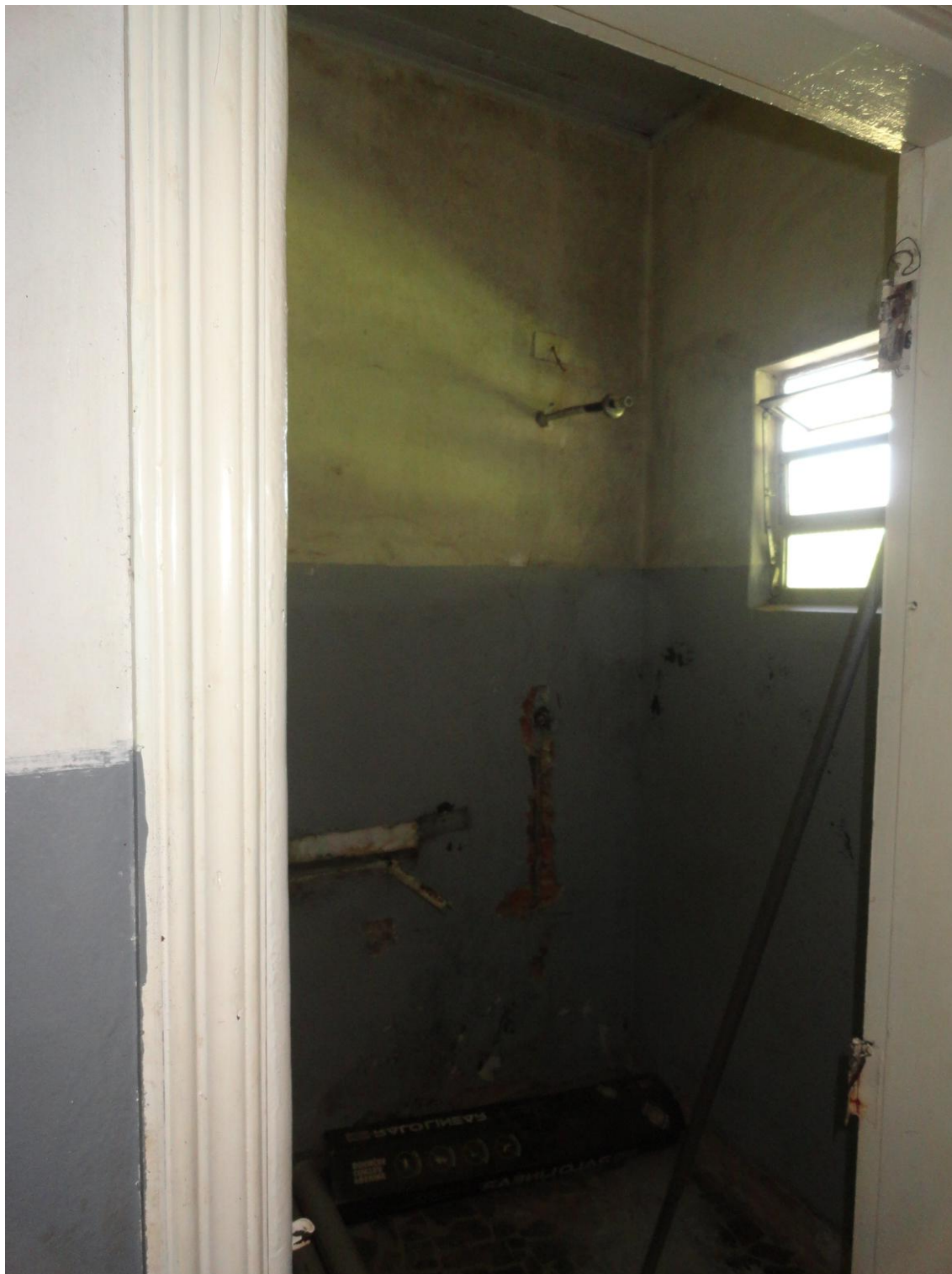
FOTO nº. 42 – 2.1.3.5. - RESIDÊNCIA CASEIRO DETALHE: Banheiro - estado de conservação.
