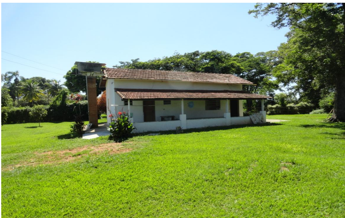
FOTO nº. 39 – 2.1.3.5. - RESIDÊNCIA CASEIRO DETALHE: Fachada
