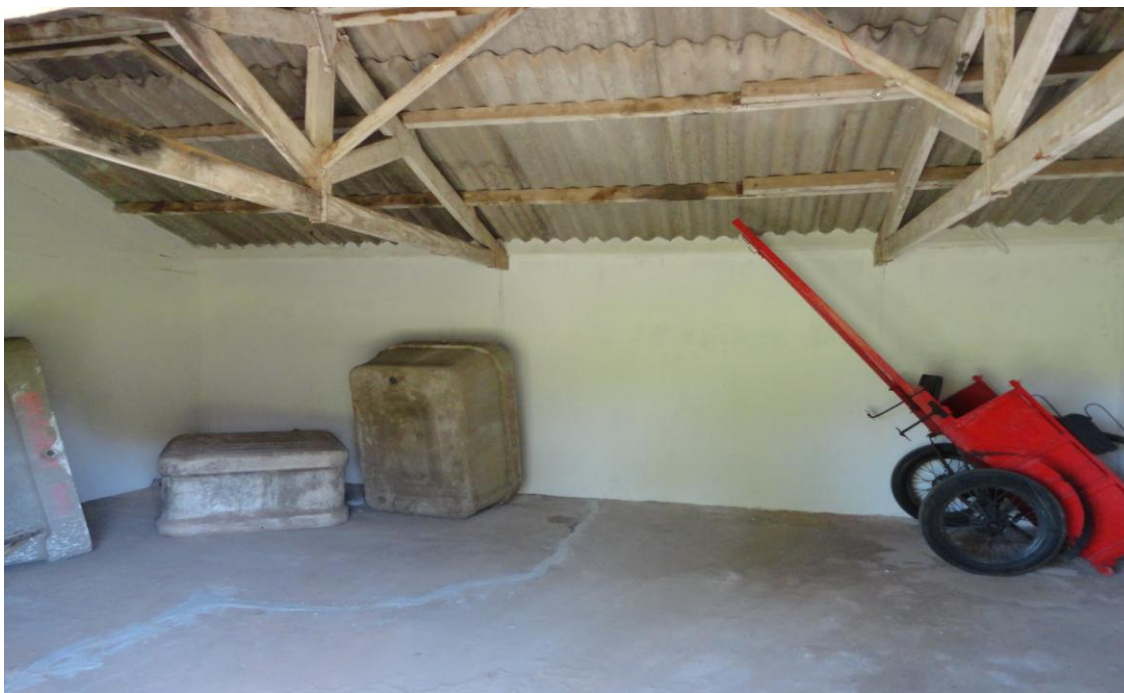
FOTO nº. 51 – 2.1.3.6. - DEPÓSITOS DETALHE: Vista interna.
