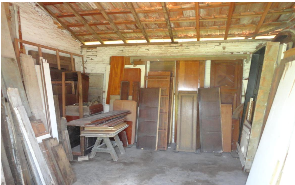
FOTO nº. 49 – 2.1.3.6. - DEPÓSITOS DETALHE: Vista interna.
