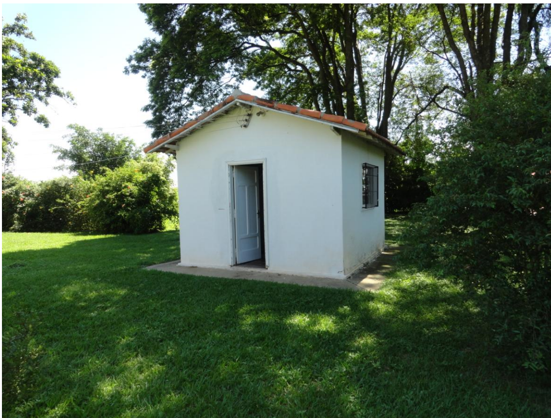
FOTO nº. 33 - 2.1.3.3. - ÁREA COM UM APARTAMENTO DETALHE: Fachada.
