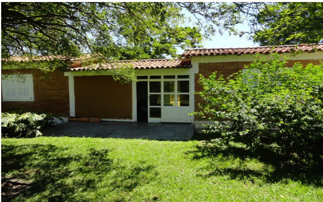
FOTO n°. 25 – 2.1.3.2. - ÁREA COM DOIS APARTAMENTOS DETALHE: Fachada
