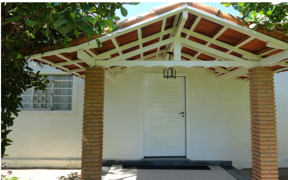
FOTO n°. 5 – 2.1.3.1. - RESIDÊNCIA PRINCIPAL DETALHE: Entrada da Residência.
