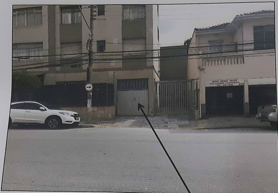
Foto 7 - Vista do acesso e veículos do Edifício Domus Flávia.
