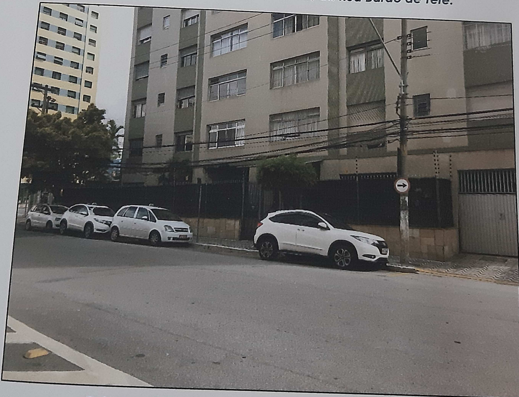
Foto 5 – Vista da portaria do Edifício Domus Flávia.
