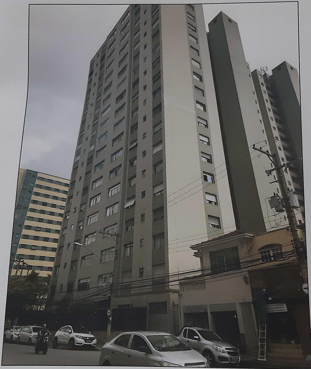
Foto 9 – Outra vista da fachada do Edifício Domus Flávia.
