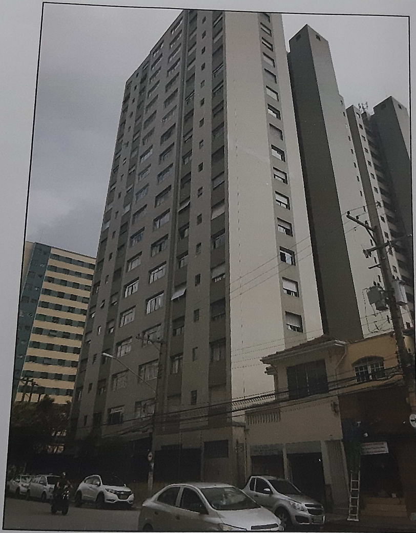
Foto 1 – Vista da Fachada do Edifício Domus Flávia
