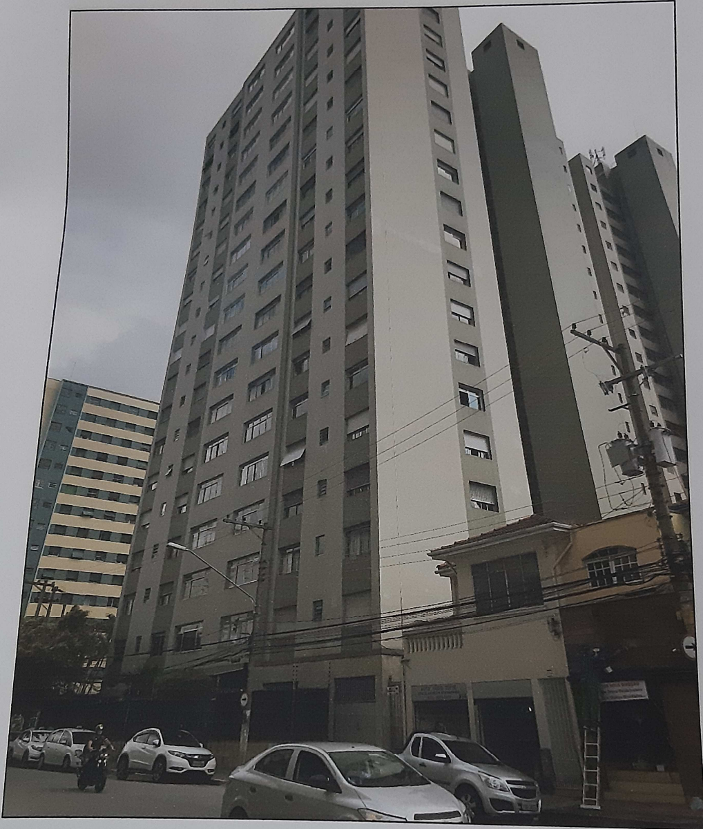
Foto 6 – Outra vista da fachada do Edifício Domus Flávia.
