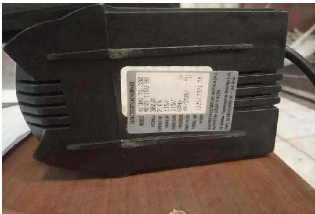
ITEM 3,035 - VISTA DA PLACA DE IDENTIFICAÇÃO DO ESTABILIZADOR MARCA: TS SHARA MOD: TS 300
