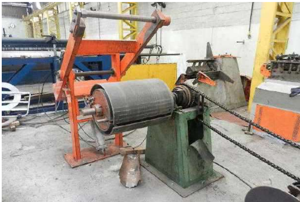
ITEM 1,018 - VISTA DO DESBOBINADOR ACIONADO POR CORRENTE DA LINHA DE CORTE
