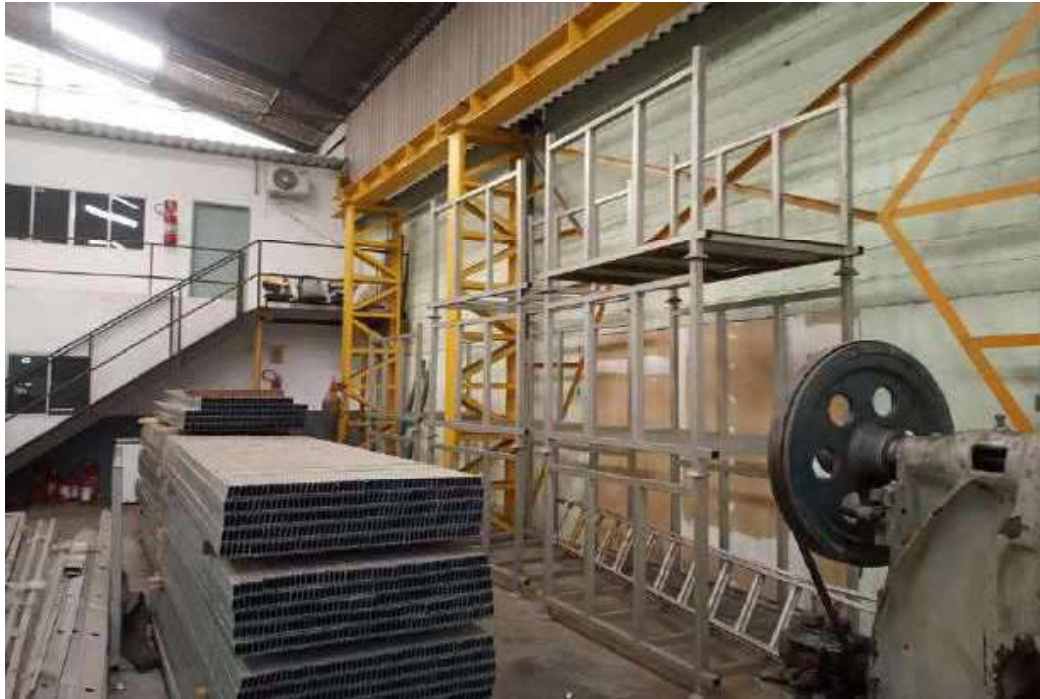
ITEM 5,017 - VISTA DO SUPORTE PARA ARMAZENAGEM
